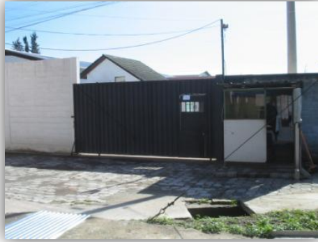
3.9 Fotografía de infraestructura de la empresa
