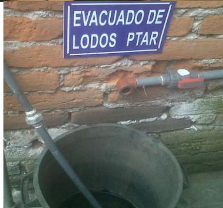
**Válvula evacuación de lodos en tanque**
