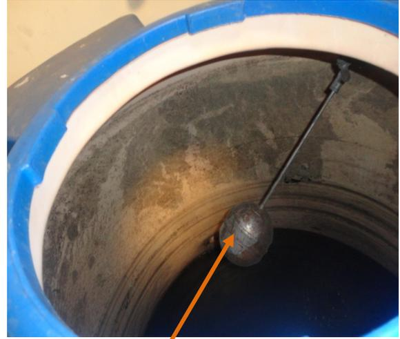
Válvula de flotador
