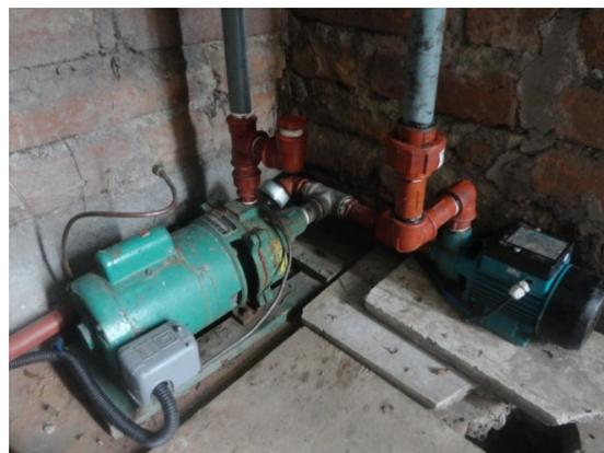
c) **Sistema de homogenización y dosificación:** lugar donde se homogeniza el agua cruda y posteriormente se dosifica el químico para el tratamiento. Cuenta con una válvula en una tubería de succión, la cual está conectada a su vez a una caneca de producto químico.
