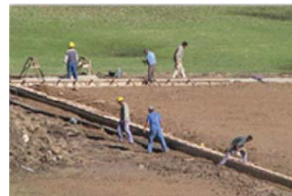
Figura 112. 3 Hormigonado de viga perimetral Fuente: pagina web: www.forbex.com/
