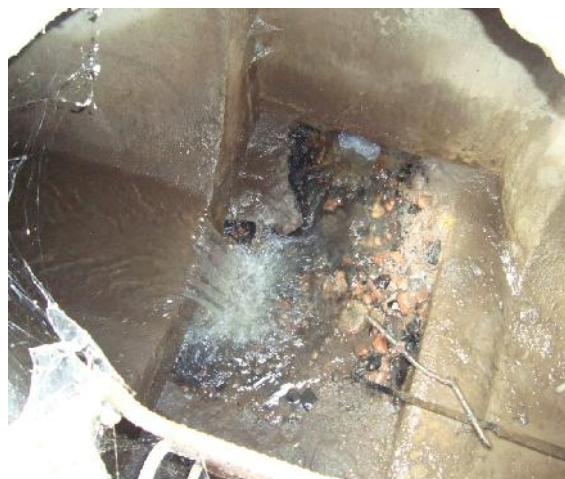
Figura N°6: Separador de Caudales
