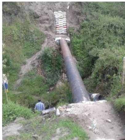
Figura N°5: Tubería de Metal para Alcantarillado
