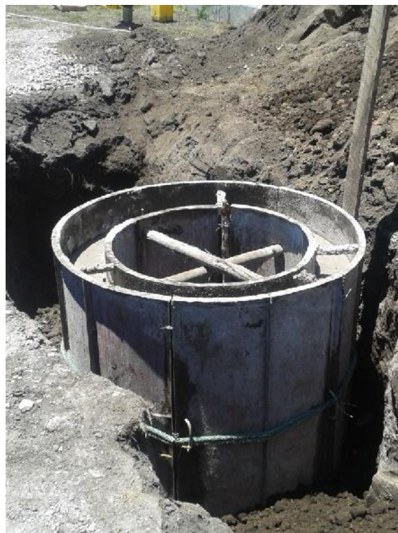
Figura N°2: Pozo de Revisión Típico
