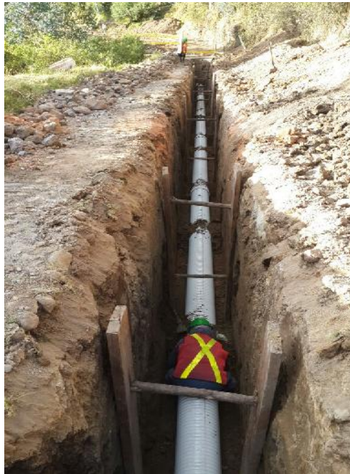
Figura N°4: Tubería de PVC para Alcantarillado
