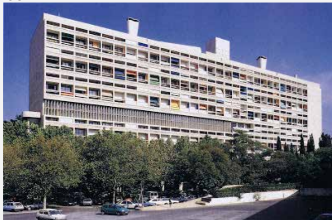
Figura 64. Conjunto Habitacional en Marsella Tomado de (Plataforma, s.f.)
