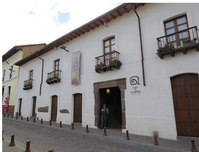
Figura 21. Fachada Principal del Museo del Alabado.
