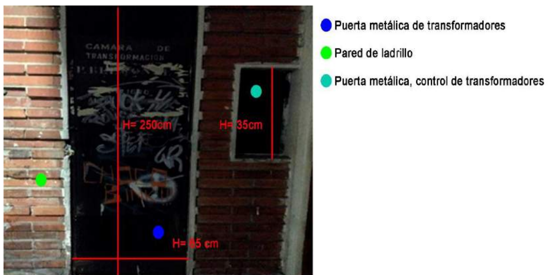
Figura 71. Cajas de revisión y medidores de energía eléctrica de la Plaza de Toros Belmonte.
