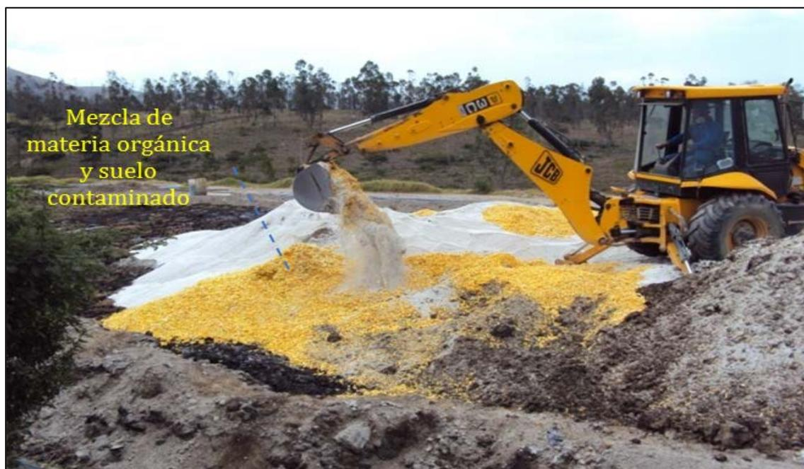
Figura 20. Mezclado con el material absorbente y orgánico
