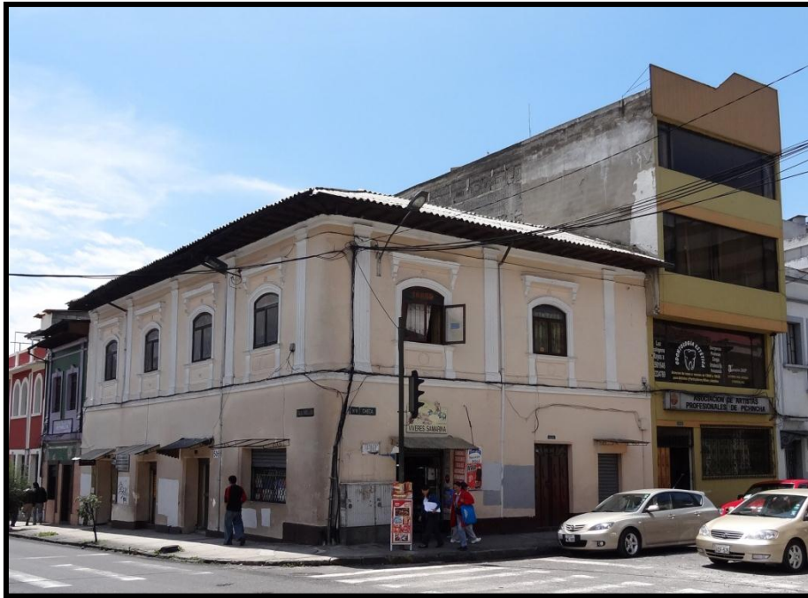
Foto 4.18: Vista de las Edificaciones
