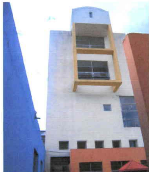
Vista fachada posterior
