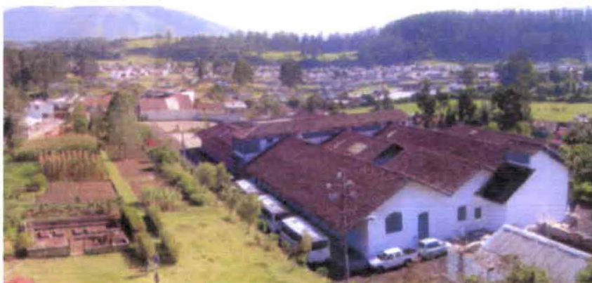
Panorámica del Centro de Convenciones de FGE
