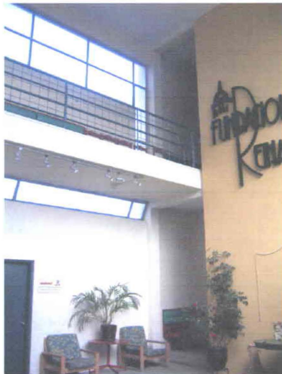
Pasamanos tubulares con malla metálica
