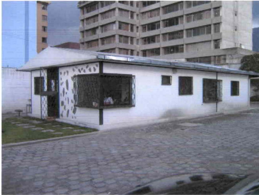
Vista frontal: Área Administrativa FRQ
