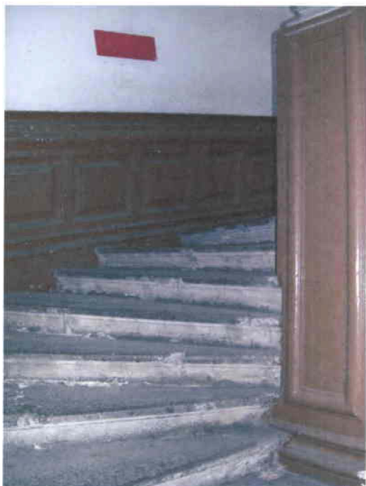
Foto personal N° 36 Escalera de piedra original
