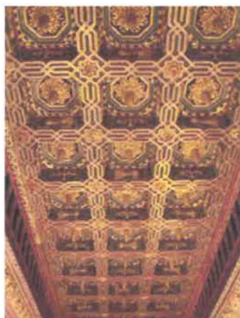
Foto N° 4 Techo estilo mudéjar
