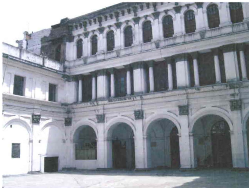
Foto personal N°31 Vista desde el patio Sur
