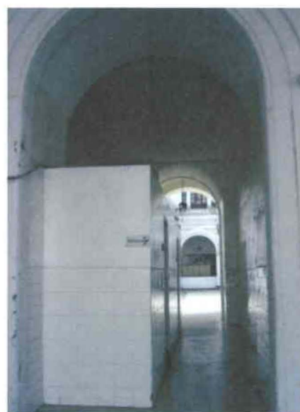
Foto personal N°60 Baños (deambulatorio empedrado que conecta el patio norte y sur)
