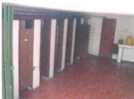
Foto personal N° 46 Baños en el subsuelo acceso patio norte
