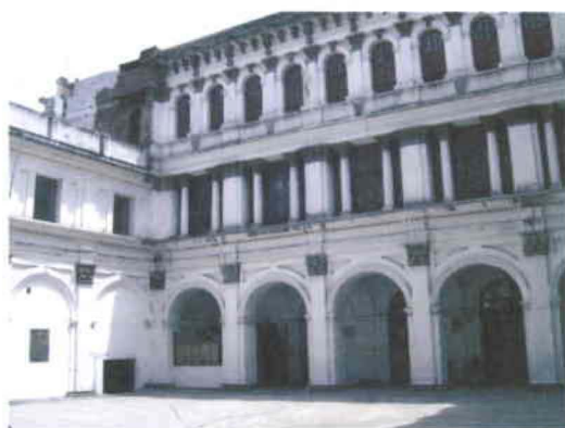
Foto N° 6 Interior del Colegio
