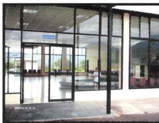
Ingreso sala de arribo
