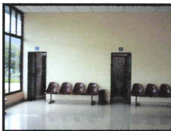
Baterías Sanitarias Sala de Arribo
