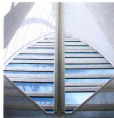
Foto 2.32. Estructura de ventanales *
