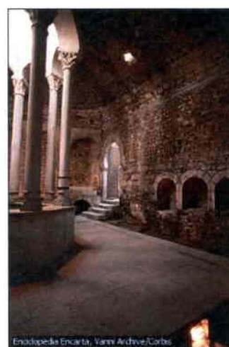
Foto 2.16. Baños árabes de Girona.*
