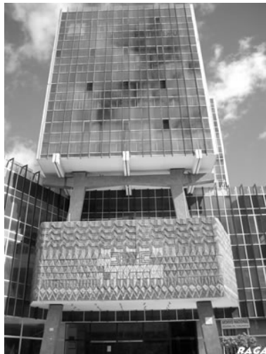
Antigua edificación Banco Central del Ecuador
