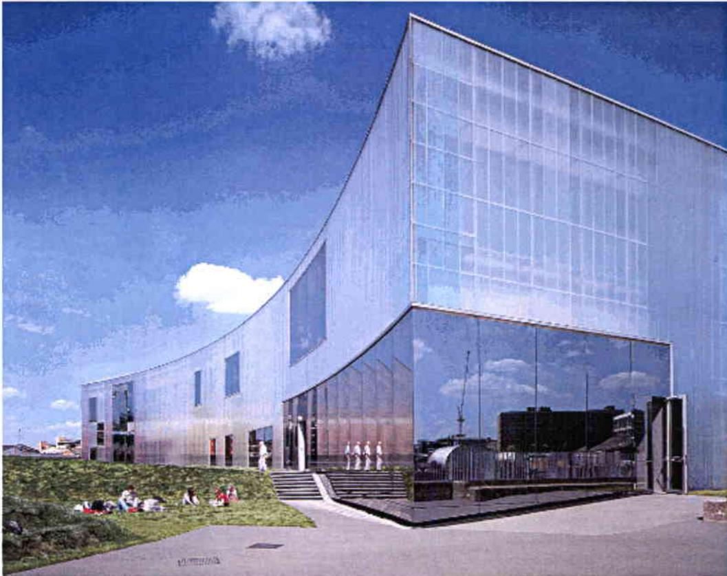
Es el edificio, dedicado específica e íntegramente a la danza, más grande del mundo, una sola de sus plantas es de 90m x 60m. Fue construido en 1998 en Londres, inaugurado en el 2003 y diseñado por los arquitectos Herzog & de Meuron. Sus imponentes fachadas con panelería de policarbonato, son uno de los elementos característicos del Centro Laban.
