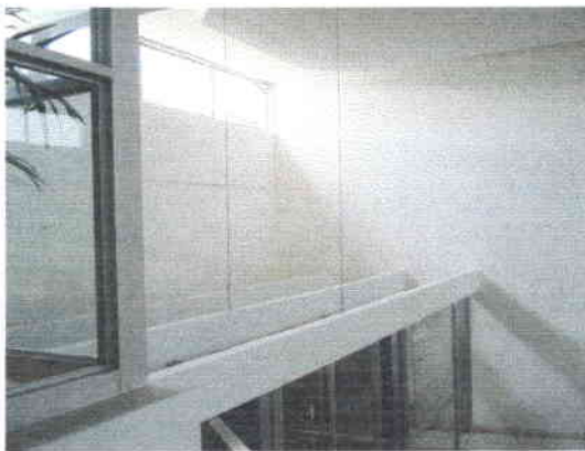
Vigas y columna
