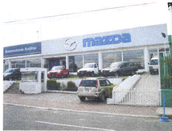
Fachada del edificio y adosamiento
