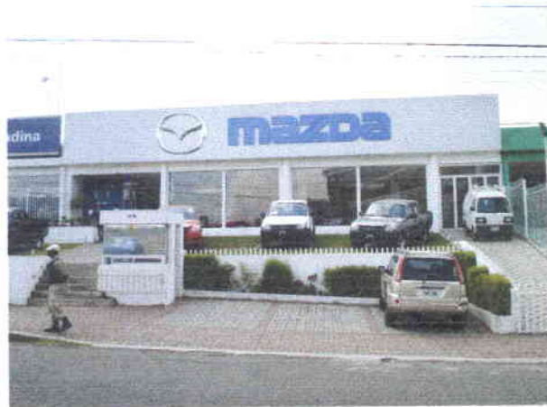
Bajantes en fachada
