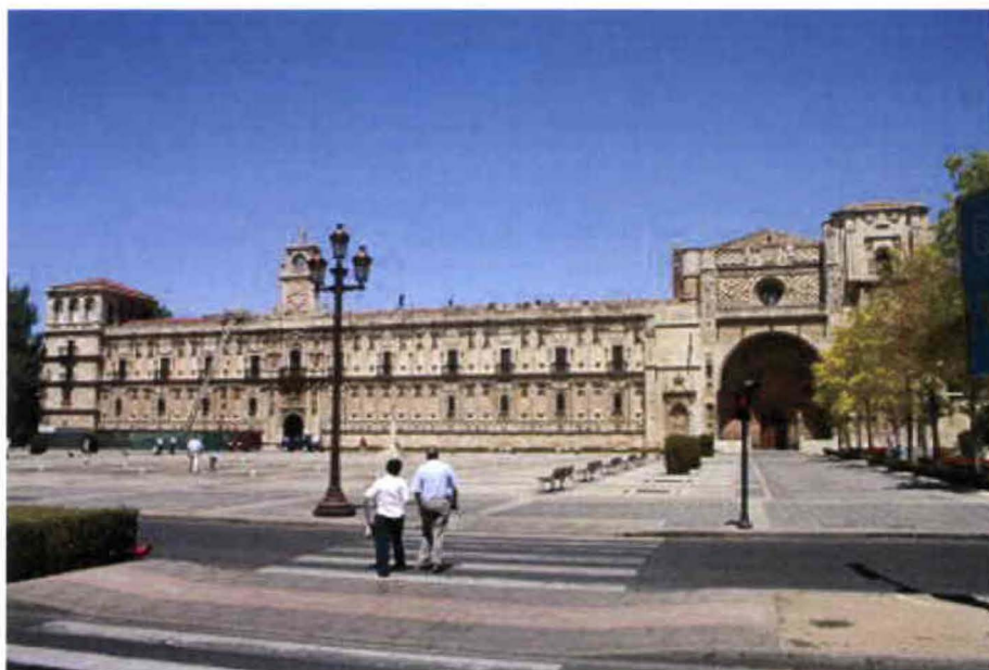
FACHADA DE HOTEL SAN MARCOS
