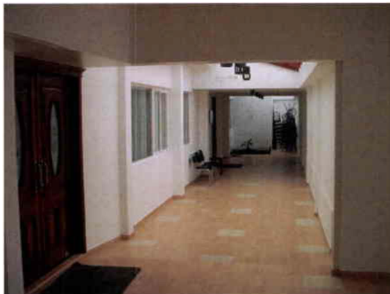
(Fotografía 9.33) Corredor Entrada a Módulos de Reuniones
