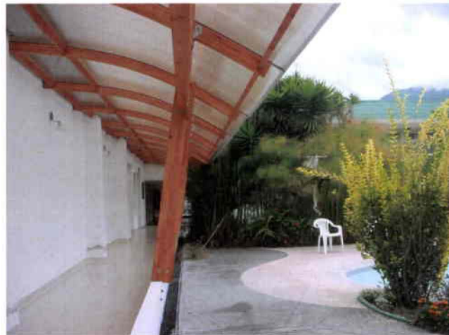
(Fotografía 6.18) Cubierta exterior para la sala de eventos
