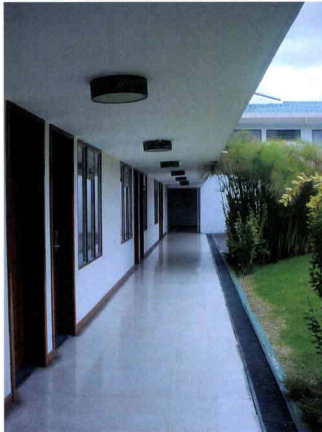
(Fotografía 6.17) Corredor de habitaciones exteriores
