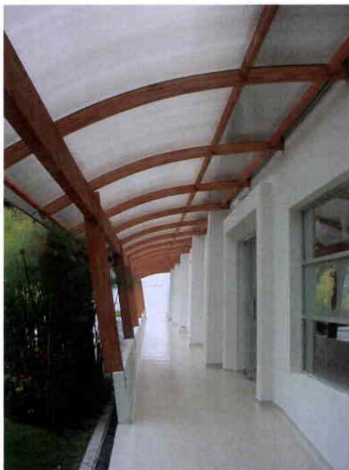
(Fotografía 6.19) Cubierta exterior para la sala de eventos
