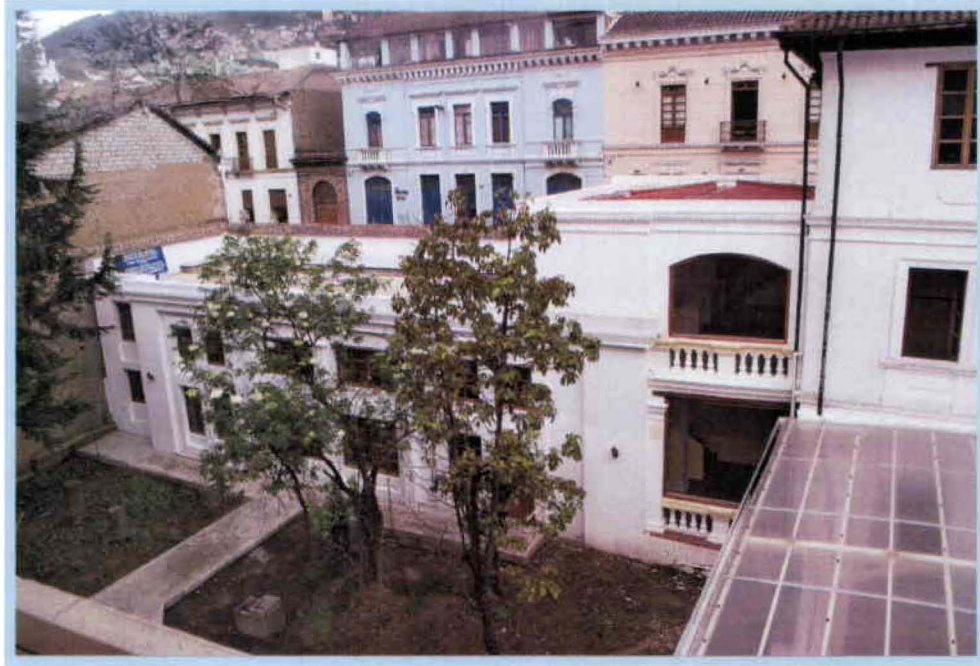
Fotografía N°30 – Vista del Nuevo bloque
