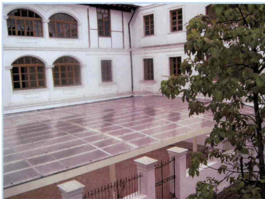
Fotografía N° 34 – Cubierta de Policarbonato, Patio Central
