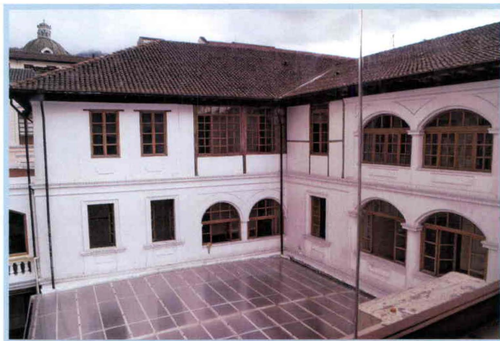
Fotografía N° 29 – Vista Fachadas internas CASA INEDES
