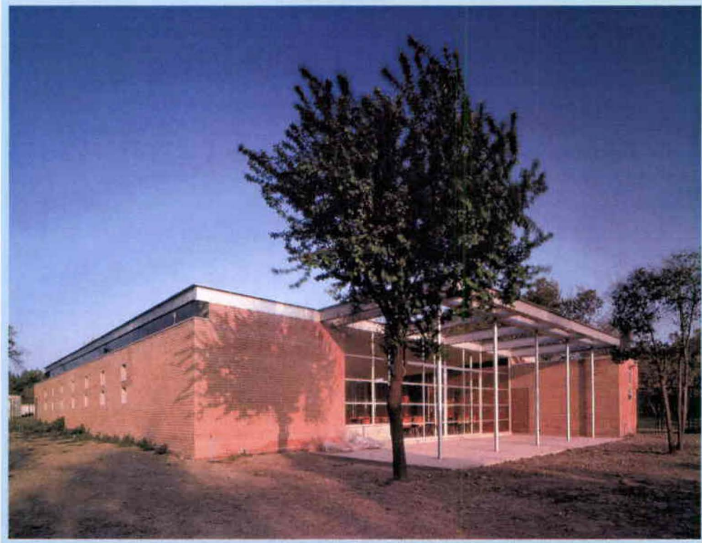
Fotografía N° 9 – Vista exterior Hogar de niños
