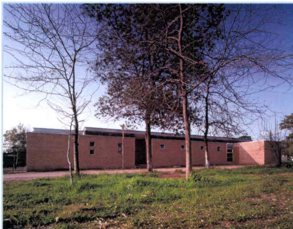
Fotografía N° 13 – Vista Exterior Hogar de niños
