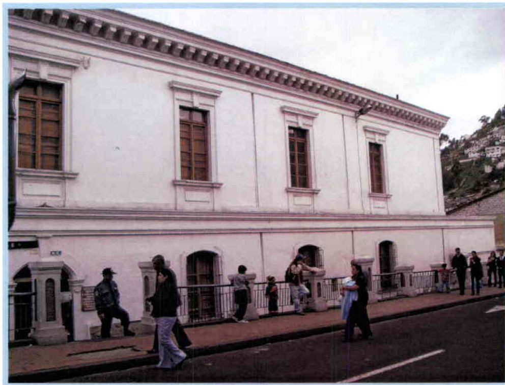
Fotografía N°28 – Vista exterior Casa INEDES ( desde la calle Venezuela )
