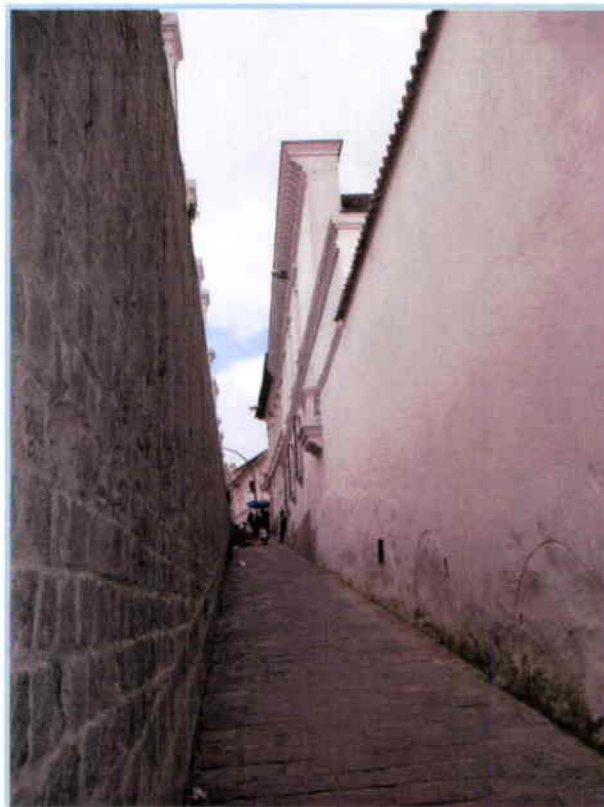
Fotografía N° 31 – Vista exterior de los muros portantes
