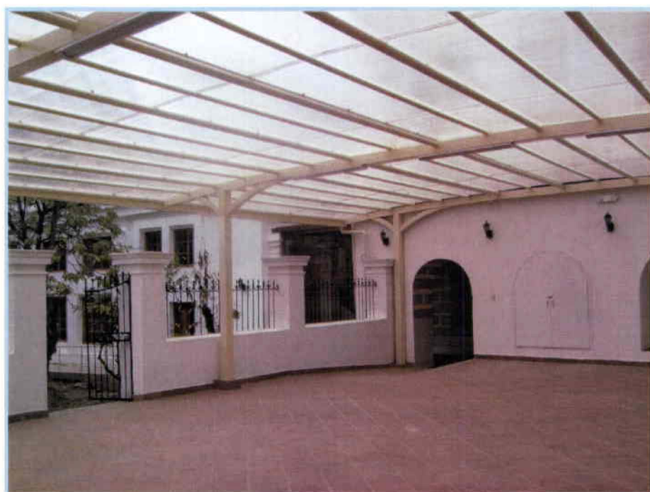
Fotografía N° 35 – Cubierta de Policarbonato, Patio Central
