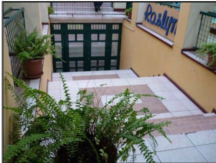
Gráfico. 4. 29 Estado Actual CCPDV
