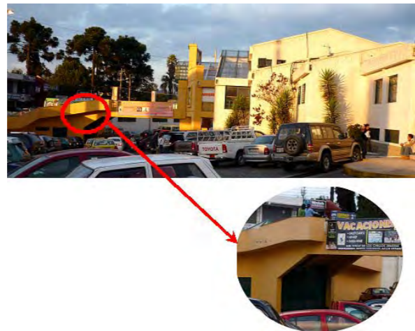
Fig. No3. Cámara de Transformación
