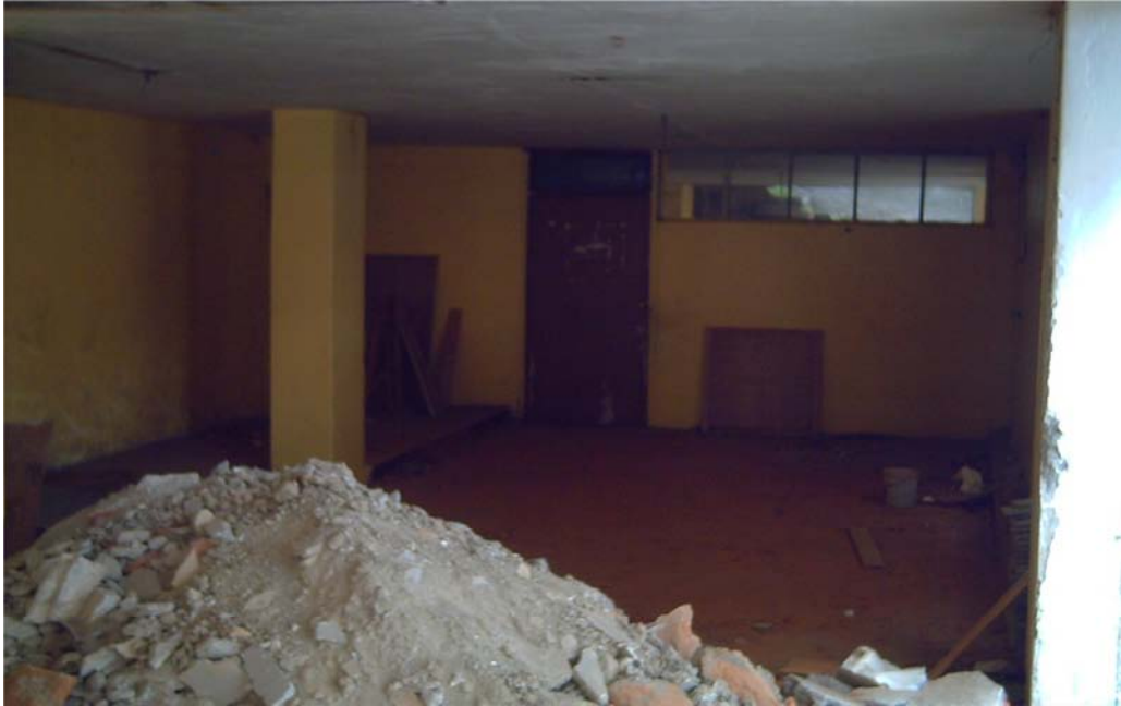
Img. 4.26, Estado actual de la primera planta alta.
