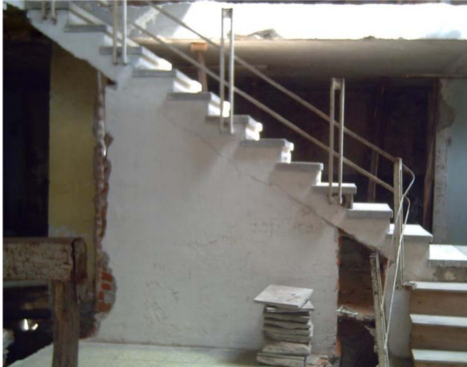
Ing. 4.20, Escaleras internas del edificio que conectan la planta baja con la primera planta alta.
