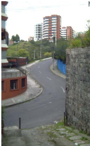
Img. 4.12, Vista desde el portón de ingreso hacia la calzada.
