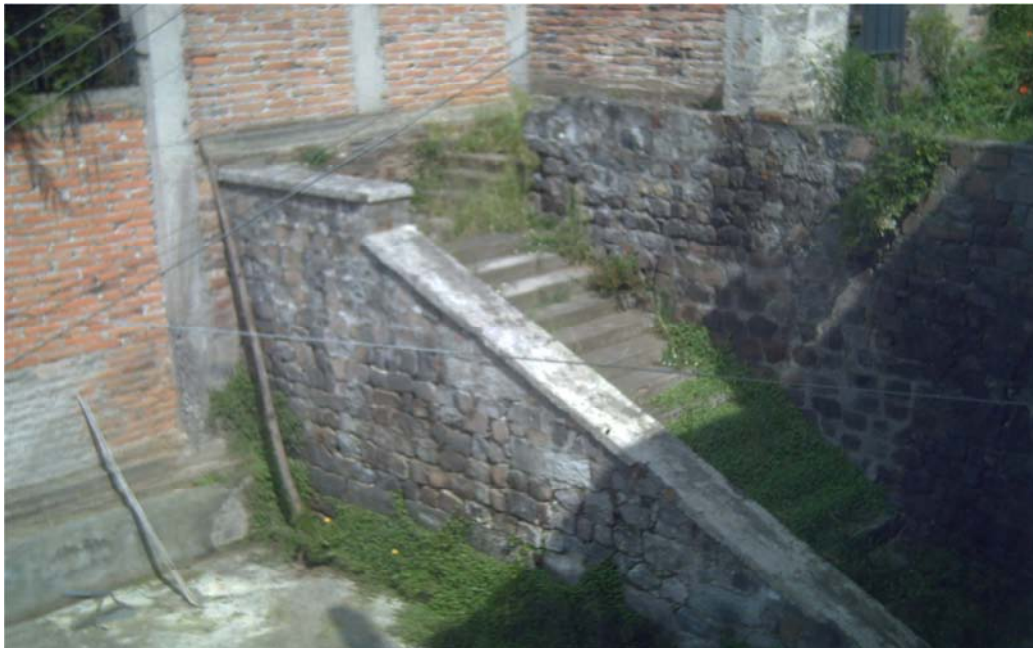
Img. 4.31, Escaleras exteriores del lado izquierdo de la edificación, que llevan a la segunda planta alta exterior.
