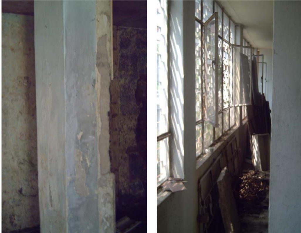
Img. 4.24, Estado actual de la estructura, mampostería y ventanería.
