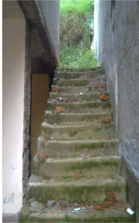
Img. 4.32, Escaleras exteriores del lado derecho de la edificación, que llevan a la segunda planta alta exterior.
