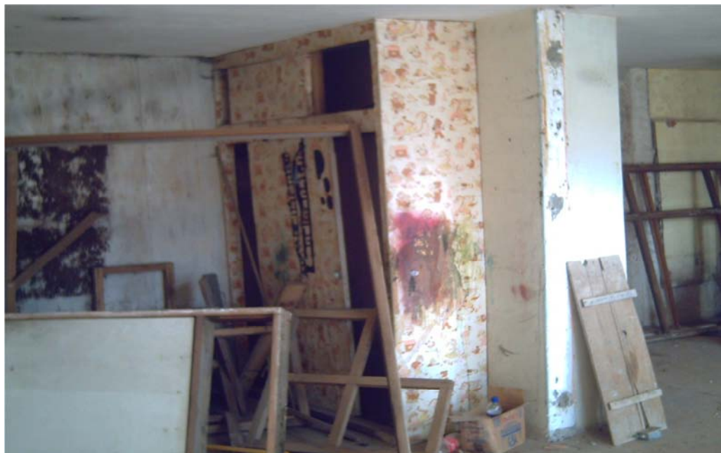
Img. 4.25, Estado actual de la primera planta alta.
