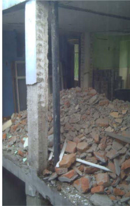
Img. 4.38, Estado actual de la tercera planta alta.
