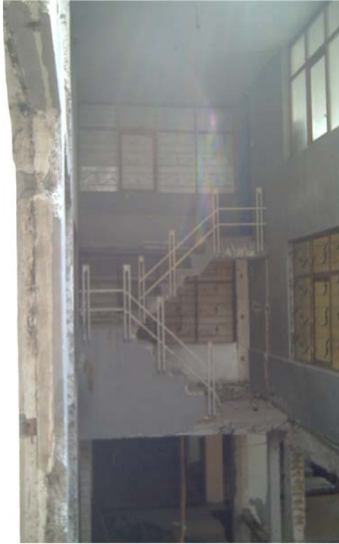
Img. 4.28, Vista desde la primera planta alta, a través del gran tragaluz que atraviesa al edificio a lo alto.
