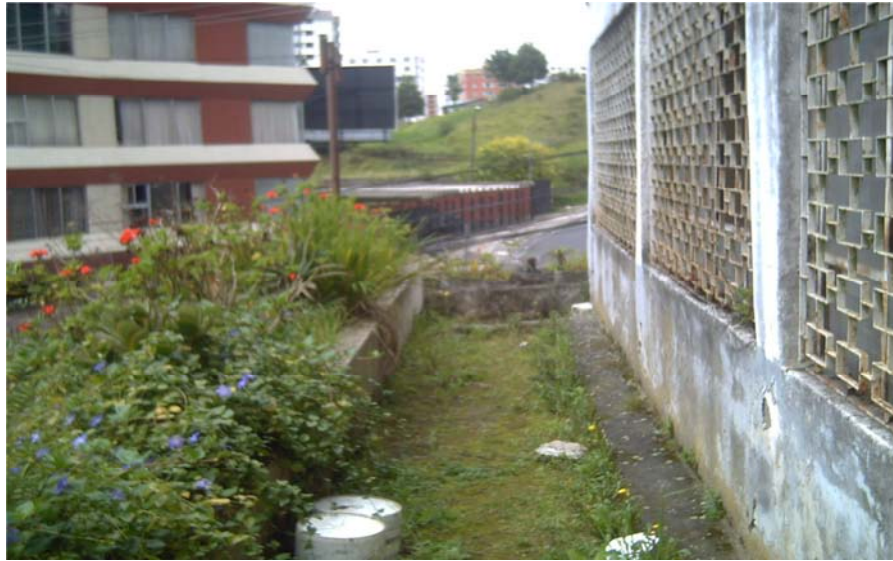
Img. 4.18, Pasillo exterior del ingreso al edificio.
