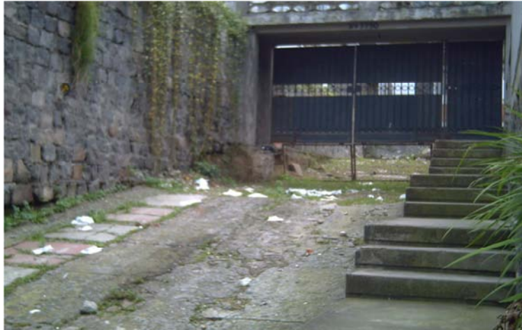
Img. 4.11, Ingreso vehicular y peatonal al edificio.
