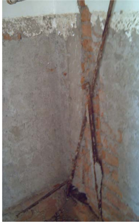
Img. 4.34, Estado actual de mampostería e instalaciones en la segunda planta alta.
