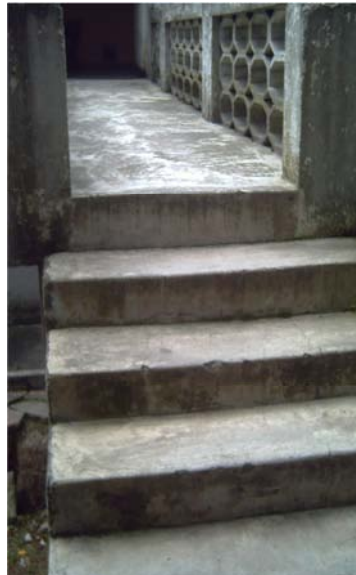
Img. 4.19, Escaleras que conectan la casa con el edificio sobre el ingreso al lote.
