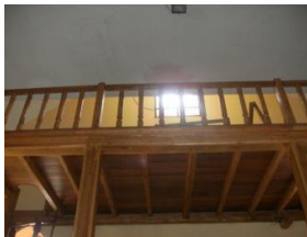
Imagen 3.29 Interior Iglesia de San Isidro
