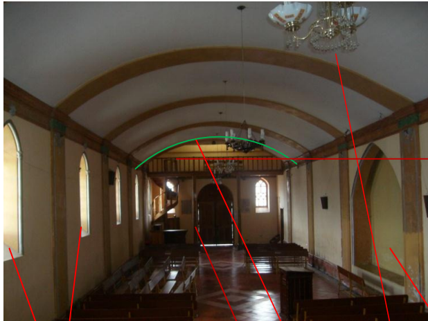
Imagen 3.24 Interior Iglesia de San Isidro
