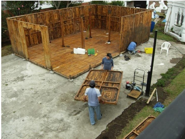
Imagen 3.15 Base de Capilla y Paredes
