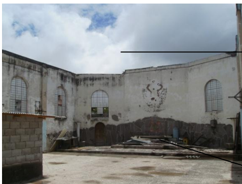
Imagen 3.32 Interior Iglesia de San Isidro
