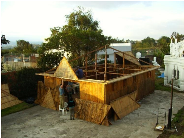
Imagen 3.16 Base de Capilla, Paredes y Techo
