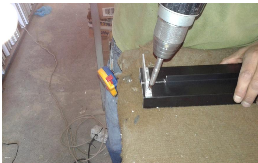
Figura 27: Colocación de anclas en el marco
