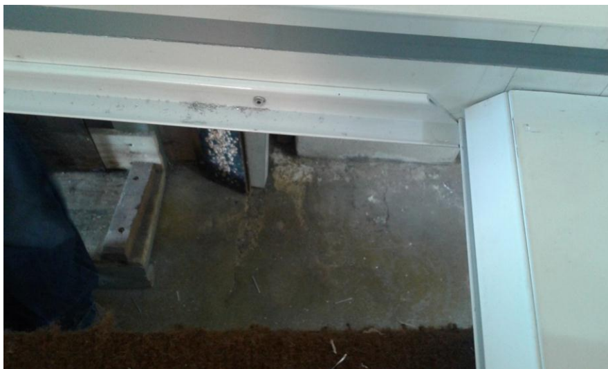
Figura 33: Colocación de junquillos horizontales a 45^\circ
