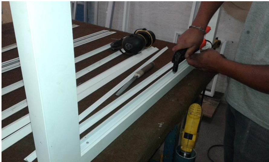
Figura 32: Colocación de junquillos laterales
