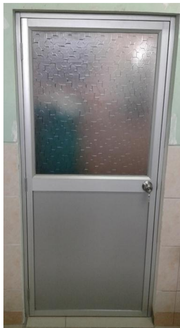
Figura 31: Colocación de junquillos laterales
