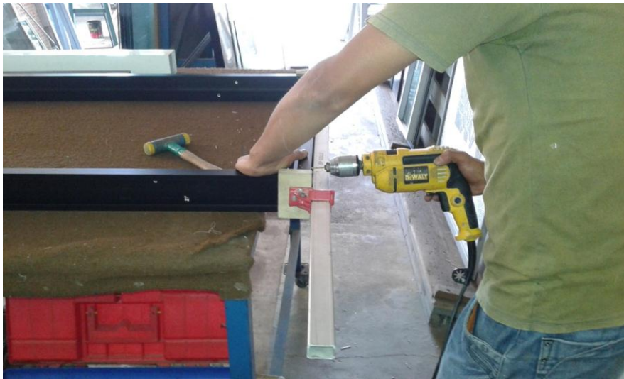
Figura 28: Colocación de anclas en el tubo
