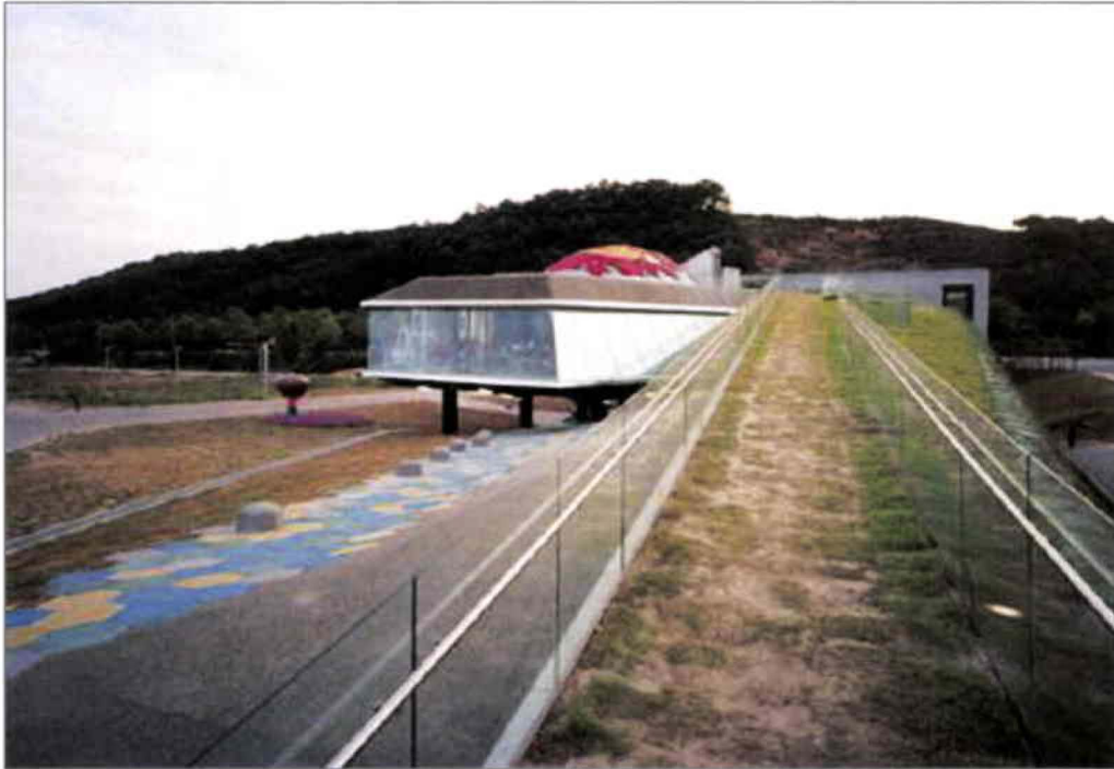
Imagen 2.8 – Rampa de acceso a cubierta
