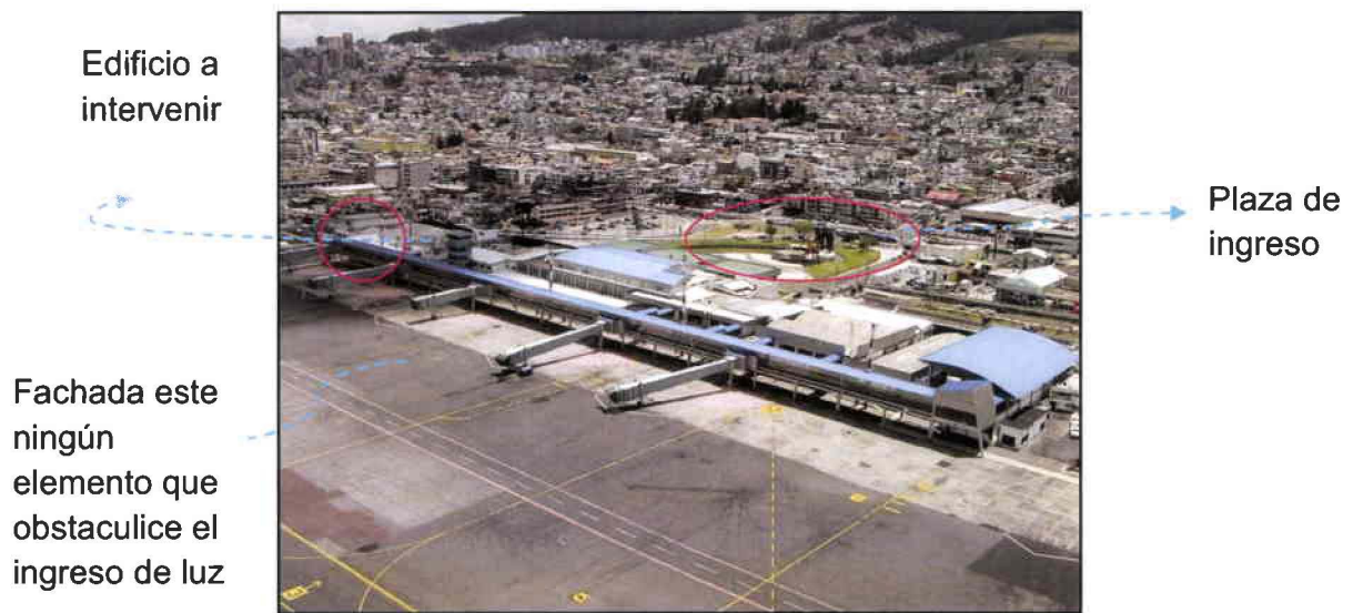
Foto 4.3 - Vista aérea las terminales aeroportuarias
