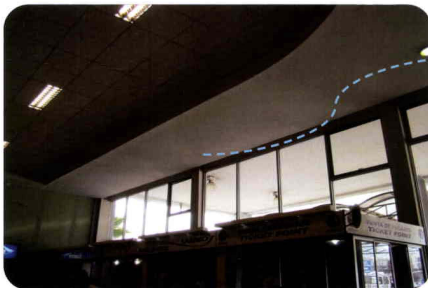
Foto 4.11 – Detalle cielo falso
