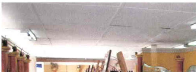
FOTO 4.13. Vista Interior del cielo raso de la "Fundación".
