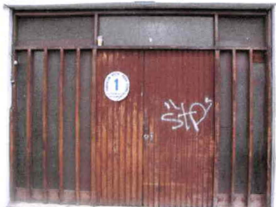
FOTO 4.21. Vista exterior de las puertas de la "Fundación".
