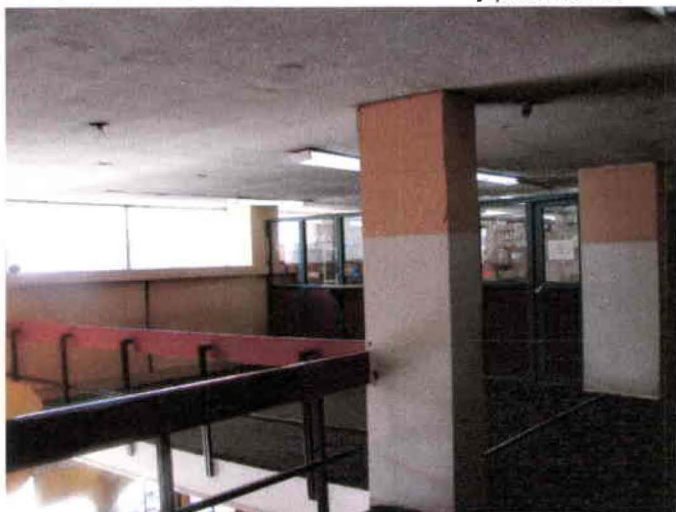
FOTO 4.18. Vista Interna de las columnas y pasamanos de la "Fundación".
