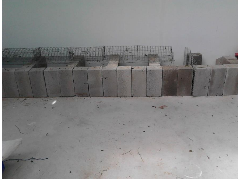
Foto1. Posas construidas con bloque.
