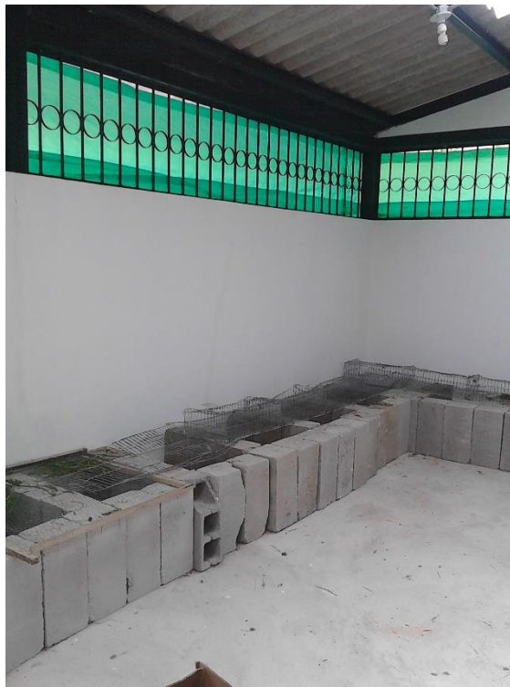
Foto 2. Posas de bloque en el interior del galpón.
