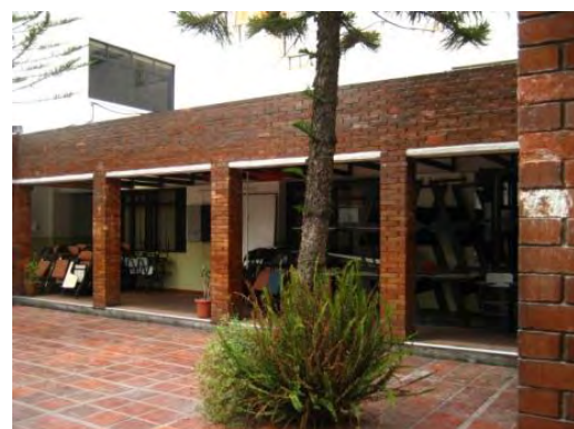
Vista desde el Ingreso 4.18
