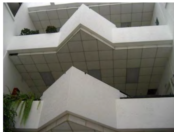
Fachada del 2do bloque 4.14
