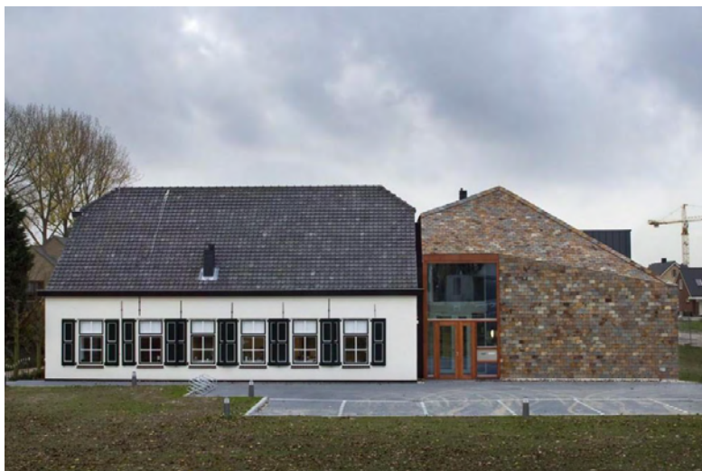
Casa Ronald McDonald, 2.13, Fachada frontal
