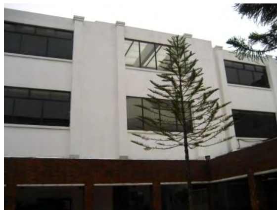
Vista desde el patio hacia el bloque principal 4.10
