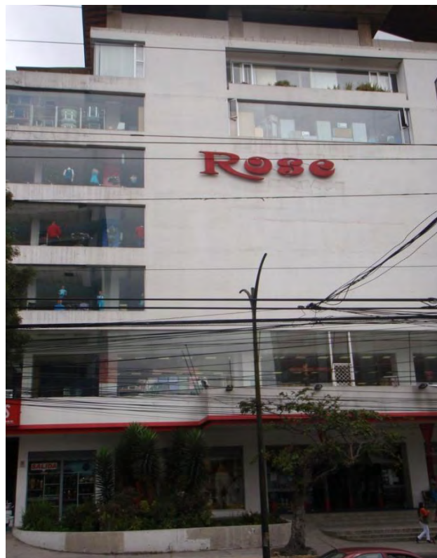
Foto 5.14 Foto fachada frontal torre II hotel Sebastián
