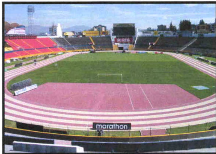
Imagen 3.9: Interior Estadio Olímpico Atahualpa.
