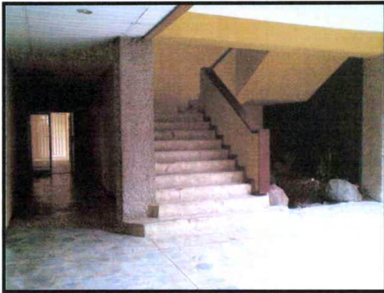
FOTOGRAFÍA INTERIOR CIRCULACIÓN VERTICAL.
