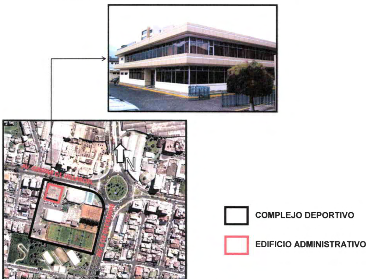
Foto 1.1: Implantación, Fachada Clínica del Deporte.
