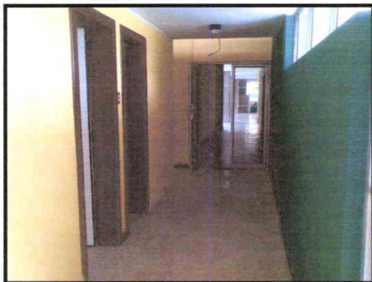
FOTOGRAFÍA INTERIOR CORREDORES ALA OESTE.
