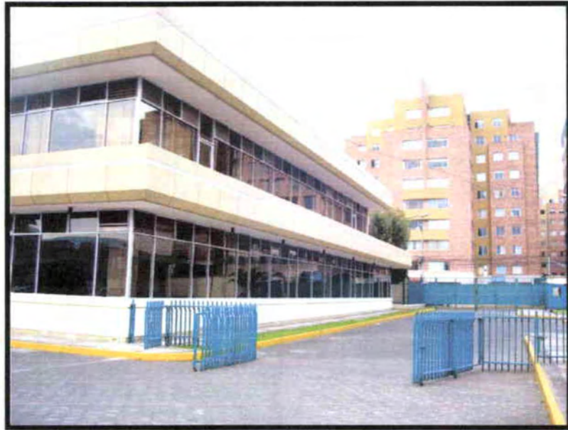
FOTOGRAFÍA EXTERIOR FACHADA ESTE.
