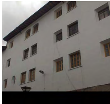
Fotografía 10.7 Fachada calle Cuenca
