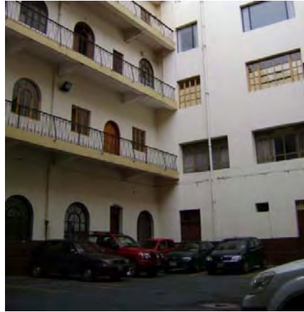
Fotografía 10.8 Fachada Calle Mideros
