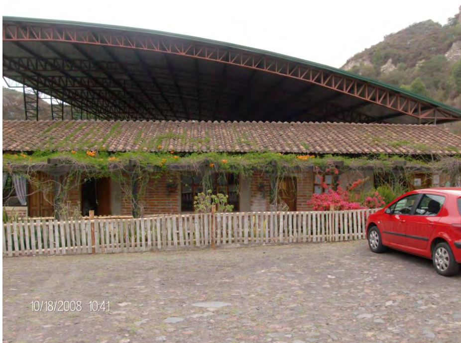
Vista módulo administrativo y estacionamientos.
