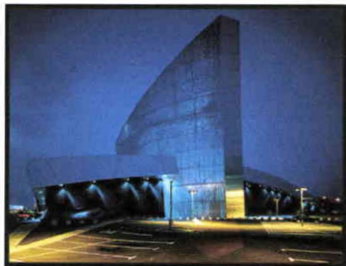
Vista exterior del edificio
