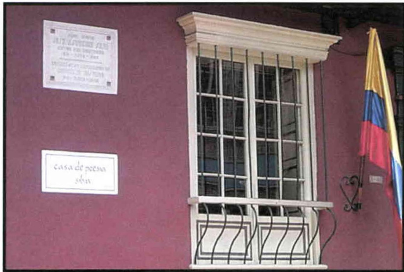
Vista exterior del edificio
