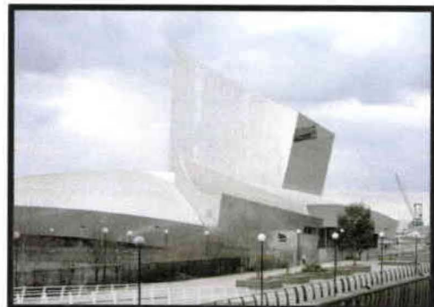
Vista exterior del edificio
