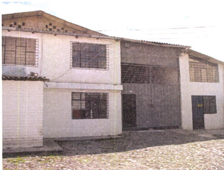
Fotografía 1.1 Fachada frontal del galpón Racks del Pacífico (Panamericana).
