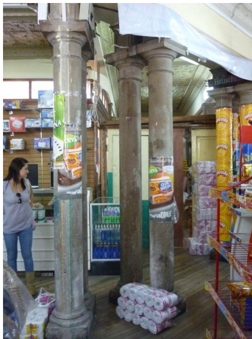
FOTO 1.11 Detalle de columnas “Antigua Caja de Pensiones del Seguro Social”
