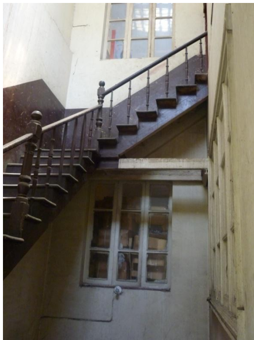
FOTO 1.9 Escalera “Antigua Caja de Pensiones del Seguro Social”
