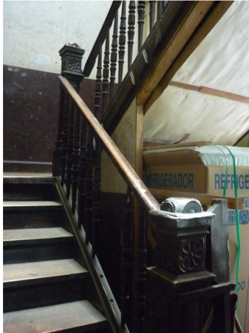
FOTO 1.10 Escalera “Antigua Caja de Pensiones del Seguro Social”
