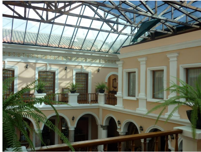
FOTO 2.53 CUBIERTA “HOTEL BOUTIQUE PATIO ANDALUZ”
