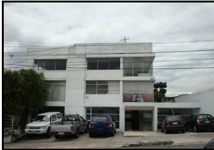
Foto 5.1 Fachada principal CEPI
