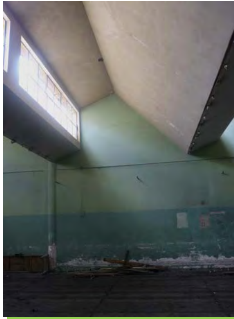
Imagen 1.5.- Pintura deteriorada
