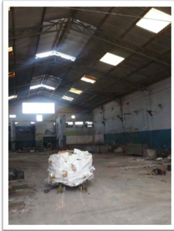
Imagen 2.1.3.- Interior de los galpones-material abandonado
