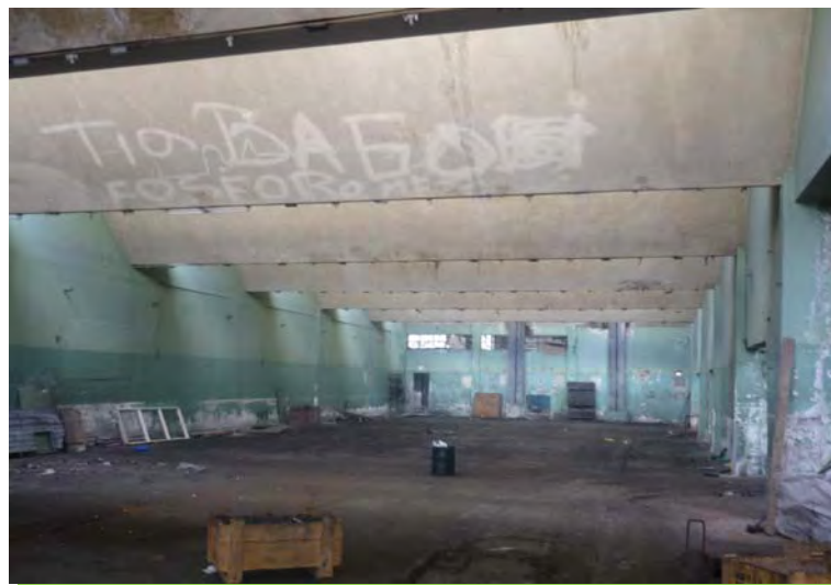
Imagen 1.4.- Galpones de la fábrica en desuso
