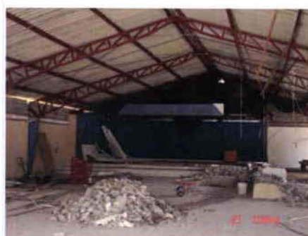
Vista Interior Pabellón Los Caras.
