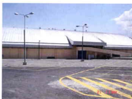
Vista Lateral Izquierda Pabellón Simón Bolívar.
