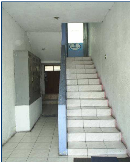
Circulación Vertical, entrada
