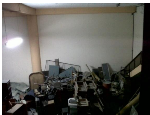
Figura 6. Estado actual espacio a intervenir.
