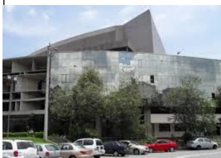
Figura 52. Ingreso al espacio a intervenir.
