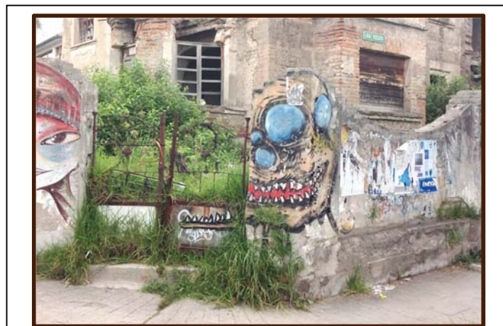
Foto 45: acceso peatonal (Lanas. 2014)
