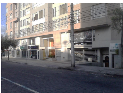
Figura 91. Ingreso al edificio y a los parqueaderos.
