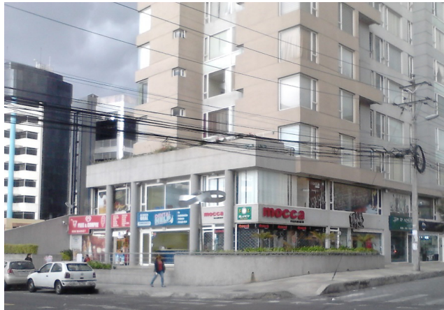
Figura 100. Vista exterior del edificio.
