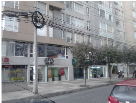
Figura 88. Edificio Korea Plaza calle Núñez de Vela.
