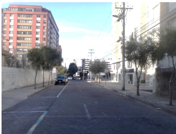
Figura 90. Edificio Korea Plaza calle Núñez de Vela.
