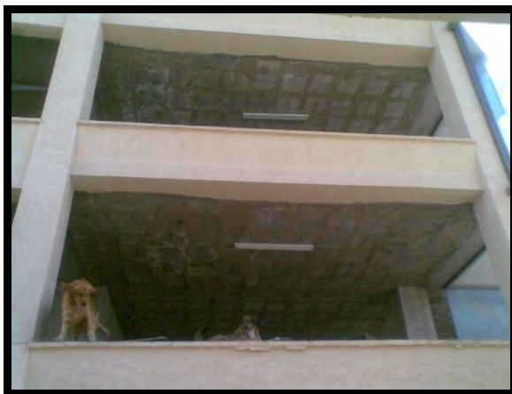
Foto 1.5: Estado Actual Interior
