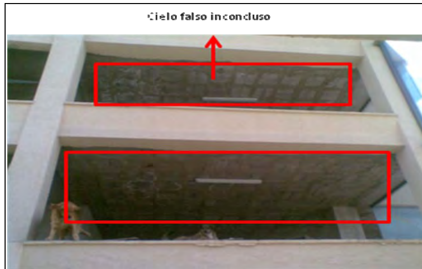
Imagen 4.5: Estado Actual Fachada Norte
