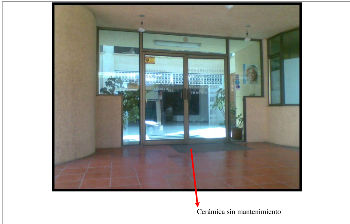
Imagen 4.8: Estado Actual Ingreso Principal Interior
