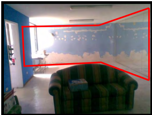
Foto 1.3: Estado Actual Interior
