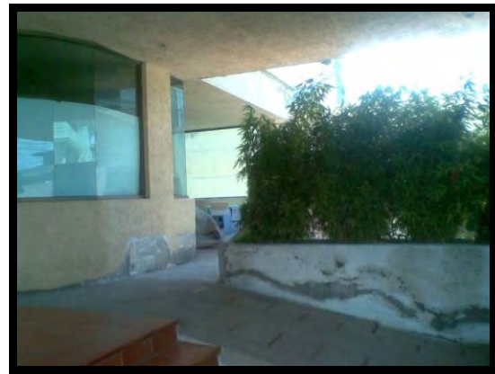
Ingreso Peatonal, rampa
