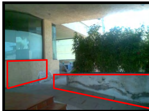
Foto 1.4: Estado Actual Exterior
