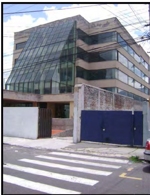
Foto 1.1: Fachada Actual Centro Infantil
