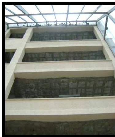
Foto 1.6: Estado Actual Interior
