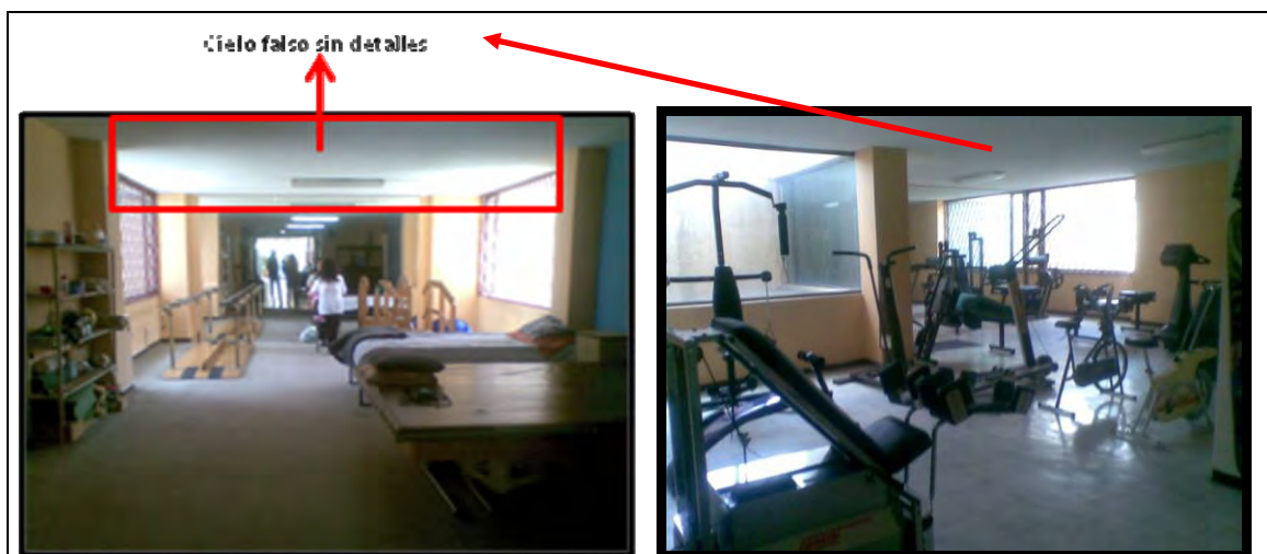
Imagen 4.9: Estado Actual Rehabilitación
