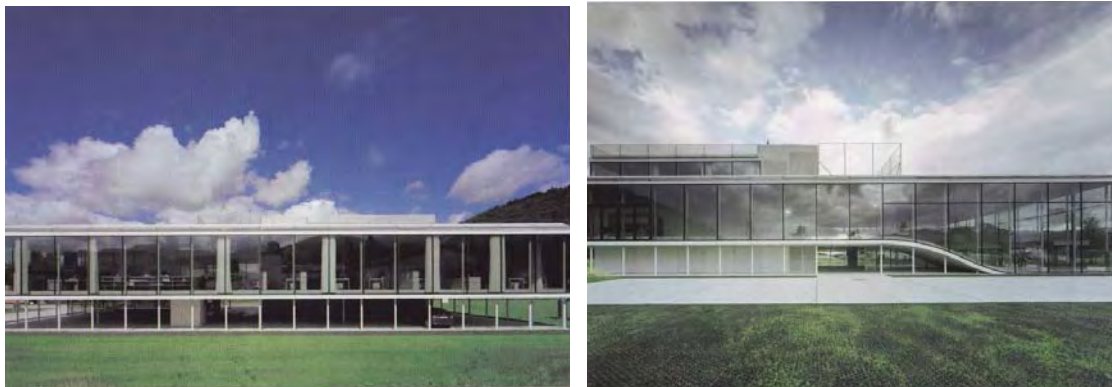
Gráfico 2.9 Diferentes vistas de exteriores del Edificio de Oficinas en Klaus
