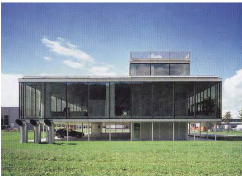
Gráfico 2.8 Fachada del Edificio Oficinas en Klaus
