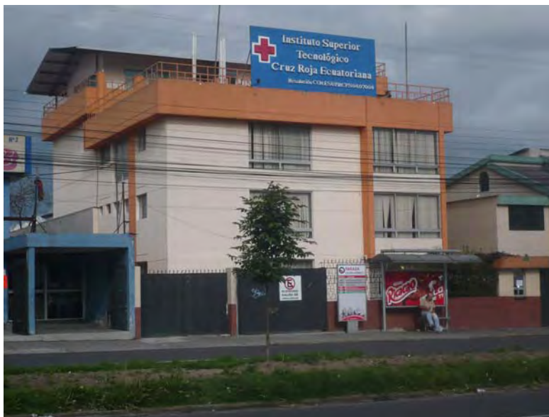
Gráfico 4.11 Fachada actual del edificio del Ins de la Cruz Roja.
