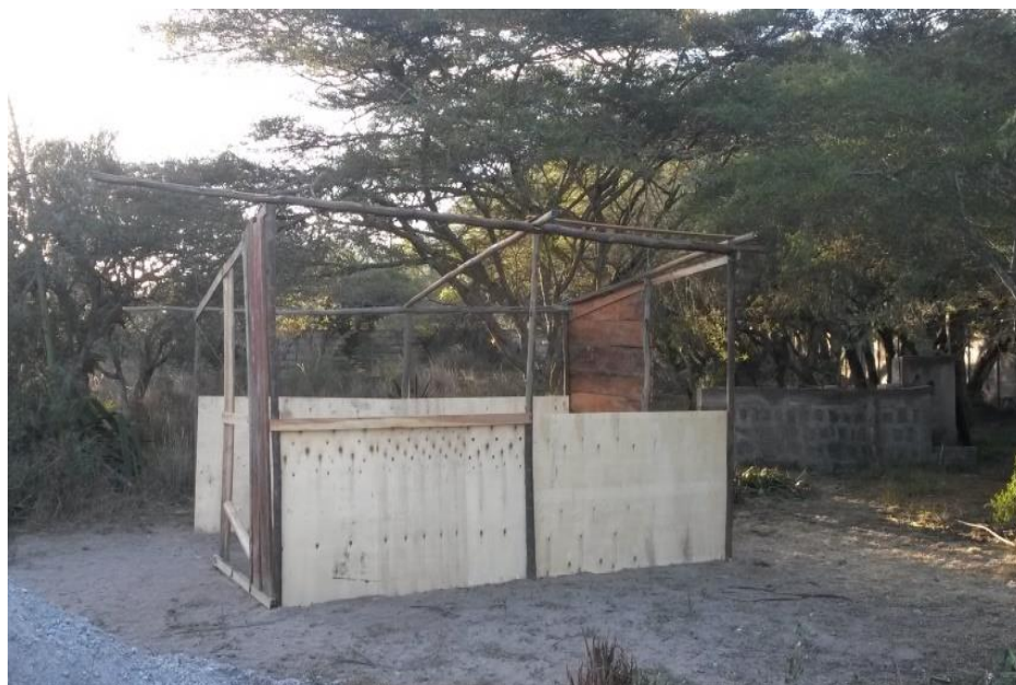
Anexo 2. Avance en la construcción del galpón.
