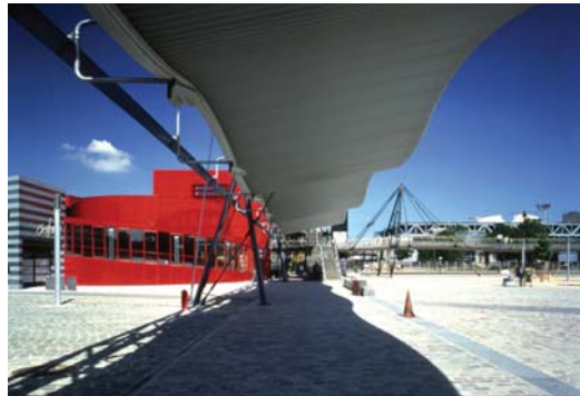
Figura 77: Imagen actual del parc de la Villette
