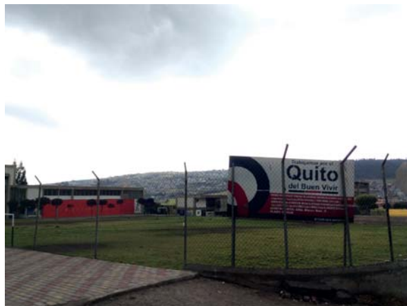
Figura 8: Imagen de la escuela del milenio Turubamba.
