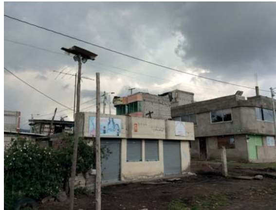
Figura 7: Imagen del estado de la edificación promedio en el sector.
