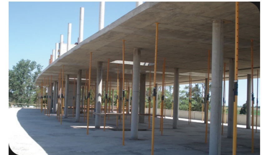
Figura 57. Estructura de Hormigón armado.
