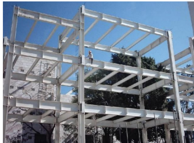
Figura 56. Estructura de acero.
