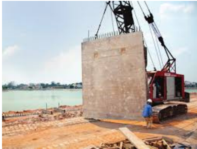
Figura 69. Diafragma de hormigón.
