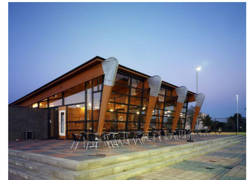
Figura 58. Estructura de madera.
