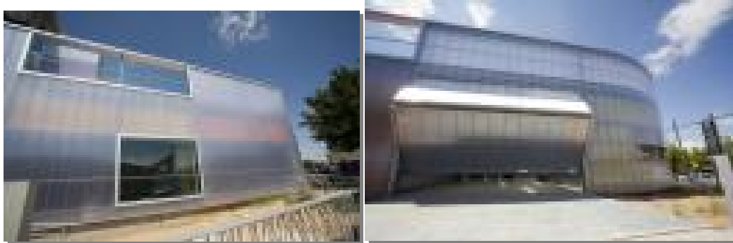
Foto 11. Fachada lateral y Acceso principal
