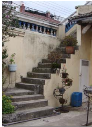
Foto 54. Escaleras de ladrillo
