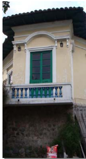
Foto 48. Zócalo de piedra
