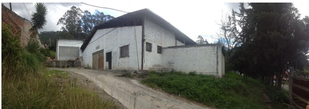
Figura 70 Tipología de la edificación
