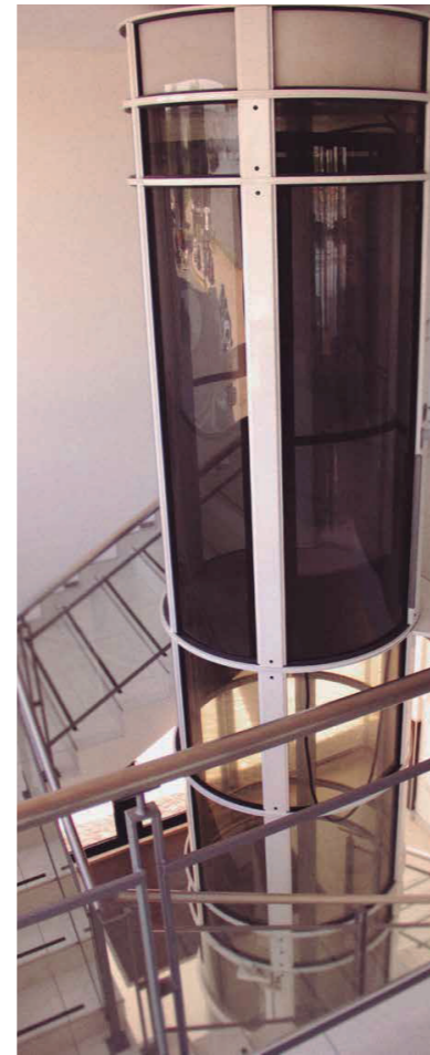
IMAGEN REAL DE ASCENSOR NEUMÁTICO EN UNA VIVIENDA
