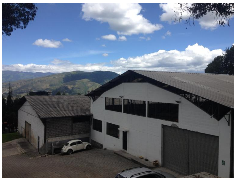
Figura 68 Vista segundo parqueadero
