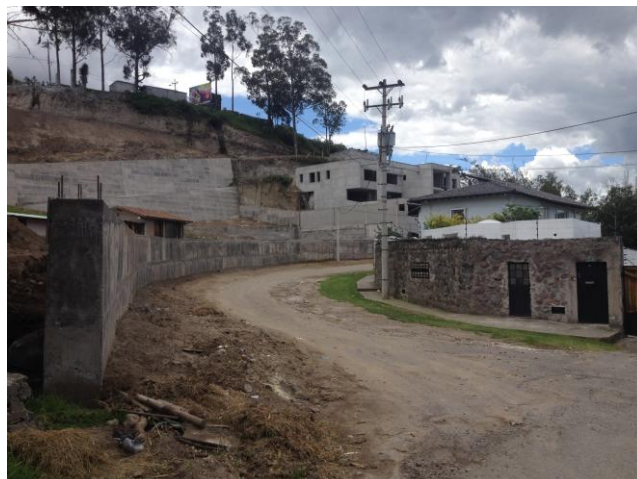
Figura 50 Continuación de la calle, no se debe seguir
