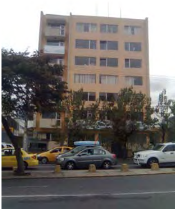
Figura 69. Fachada del edificio al cual va dirigida la propuesta
