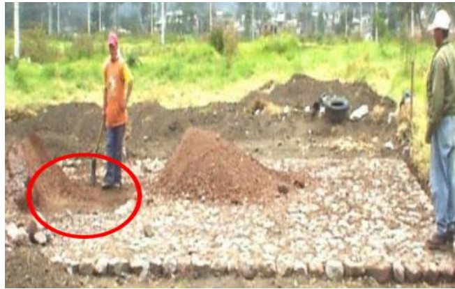
Figura 2.2.1.f.- Proceso de empedrado de la base.
