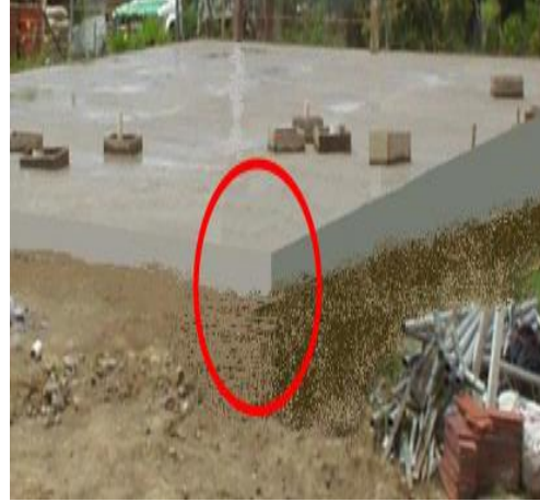
Figura 2.2.1. j.- Plataforma de hormigón.
