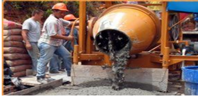
Figura 2.2.1.c.- Mezclado de hormigón
