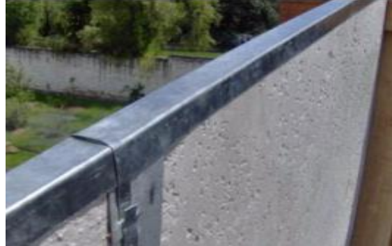
Figura 2.2.1.n.- Colocación de las soleras.
