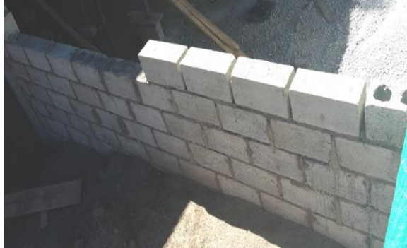
Figura 2.2.3 d.- Armado de mampostería de bloque (detalle).
