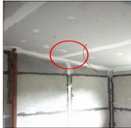
Figura 2.2.1.t'.- Abertura en los techos Figura 2.2.1.t''.- Relleno de las aberturas
