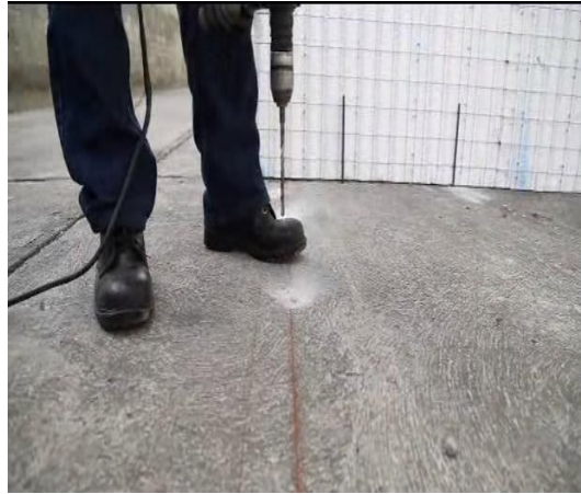
Figura 2. 2.2. I.- Marcado de los ejes de los paneles. Tomada de.- (Hormi-2, 2013)
