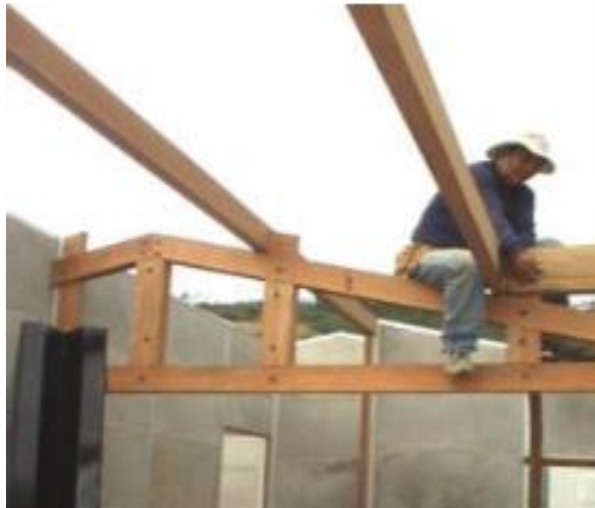
Figura 2.2.1.o.- Armado de la estructura de la cubierta.
