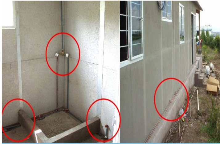
Figura 2.2.1.s.- Instalaciones hidráulicas (detalle).
