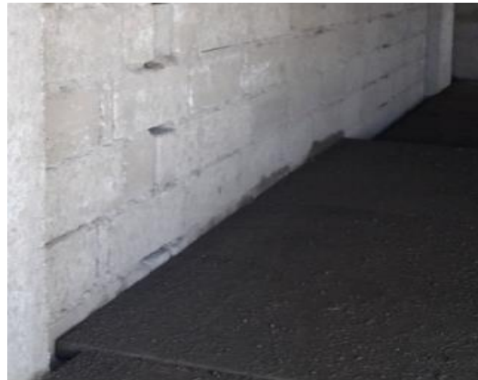
Figura 2.2.3 g.- Superficie alisada de la losa.
