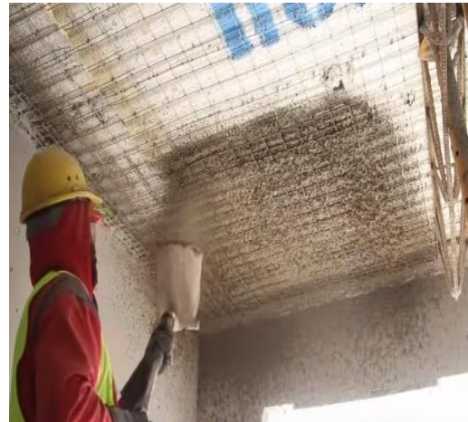
Figura 2. 2.2. s.- Montaje de la losa. Figura 2.2.2. s’.- Revoque de Losas.
