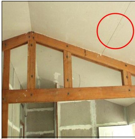
Figura 2.2.1.t'.- Abertura en los techos Figura 2.2.1.t''.- Relleno de las aberturas
