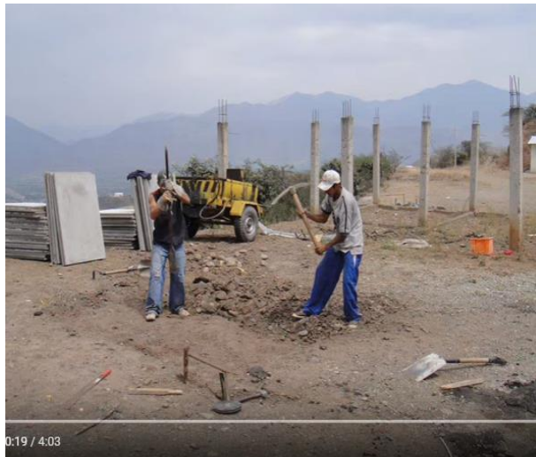
Figura 2. 2.2. h.- Cavado del terreno para el nivel de cimentación.
