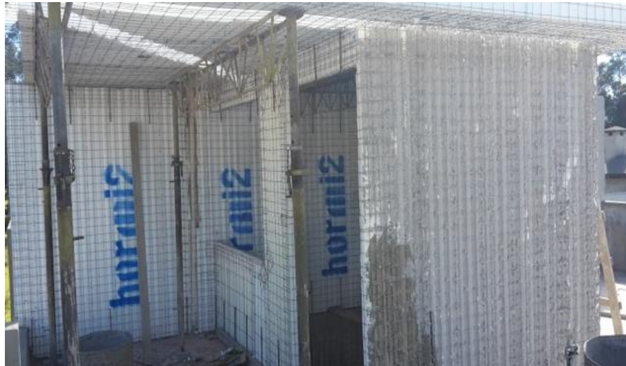
Figura 2.2.2 b.- Detalle de una obra en base de paneles modulares en plena ejecución.
