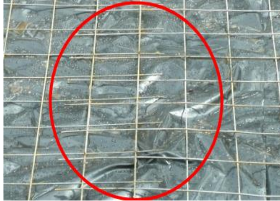
Figura 2.2.1.h.- Colocación de la malla electro soldada.
