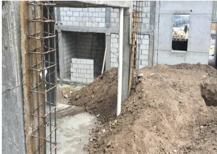
Figura 2.2.3 i .- Detalle del avance de obra.
