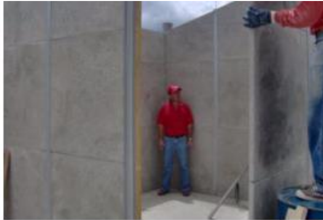
Figura 2.2.1.I.- Colocación de los paneles con sus respectivos Perfiles metálicos.
