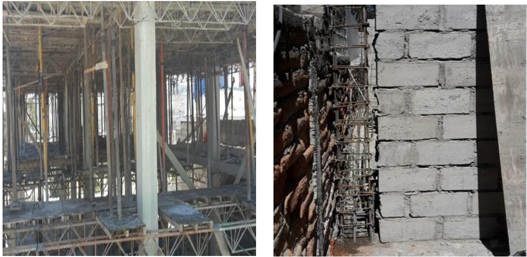
Figura 2.2.3 b.- Armado de la súper estructura (vigas y columnas)
