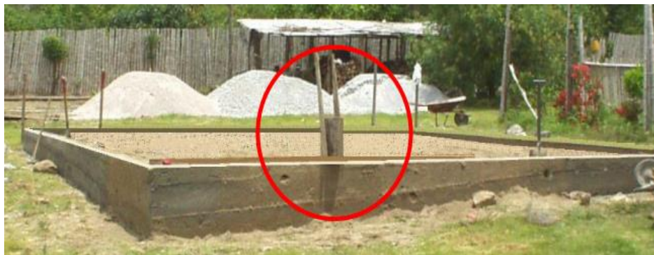
Figura 2.2.1.e.- Construcción de la base. Apisonamiento del material.
