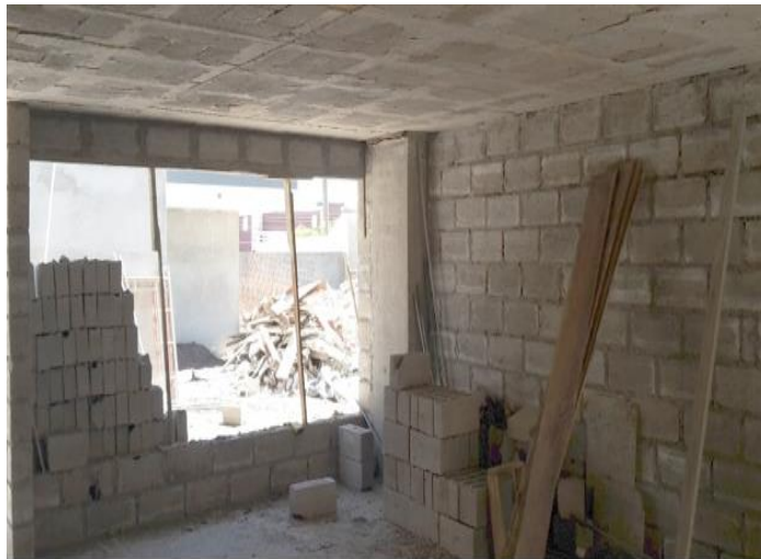
Figura 2.2.3 e.- Desarrollo de la construcción de mampostería de bloque.
