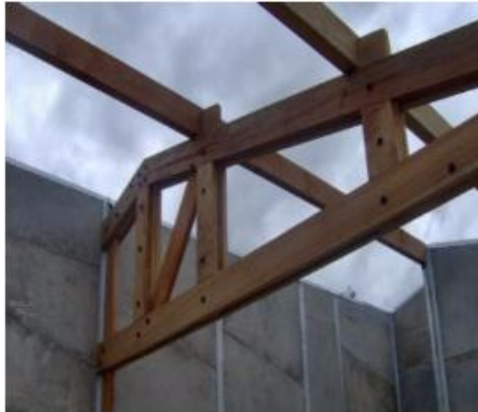
Figura 2.2.1.p.- Detalle de la estructura de cubierta.
