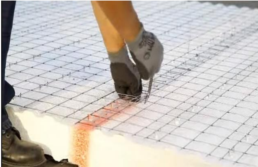
Figura 2. 2.2.n.- Traslape de mallas.
