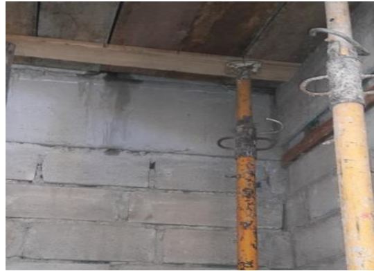
Figura 2.2.3 f.- Encofrado de la losa y apuntalamo del encofrado.
