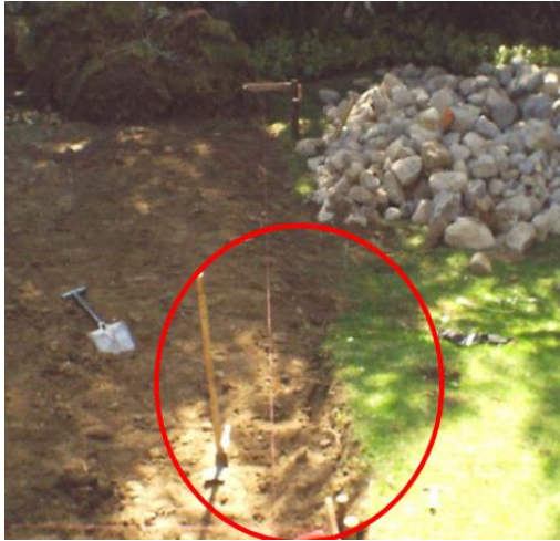
Figura 2.2.1.d'.- Preparación de la base.
