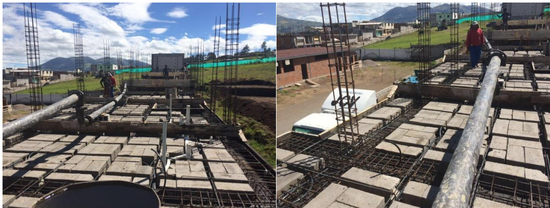
Figuras 2.2.3 g.- Detalle del proceso de armado y fundido de la losa de hormigón.
