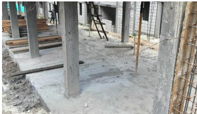
Figura 2.2.3 c.- Estructura inmediatamente desencofrada.
