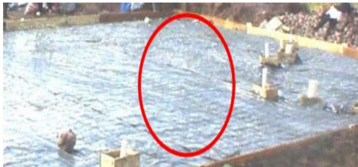
Figura 2.2.1.g.- Impermeabilización de la base.
