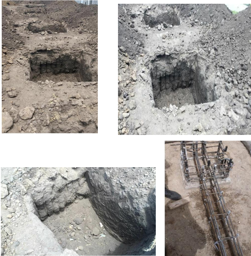
Figura 2.2.3 a.- Excavación para la construcción de plintos.
