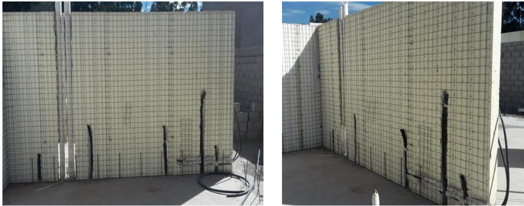
Figura 2. 2.2 .q.- Colocación de instalaciones. Figura 2. 2.2 q´.- Colocación de instalaciones
