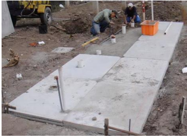
Figura 2. 2.2. k.- Construcción de la base de la vivienda. Tomada de.- (Briceño, 2011)
