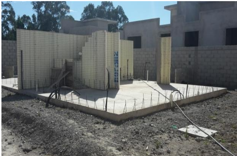
Figura 2.2.2 a.- Construcción de vivienda de panel modular.
