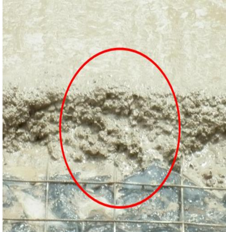
Figura 2.2.1.i.- Colocación de la Capa terminada
