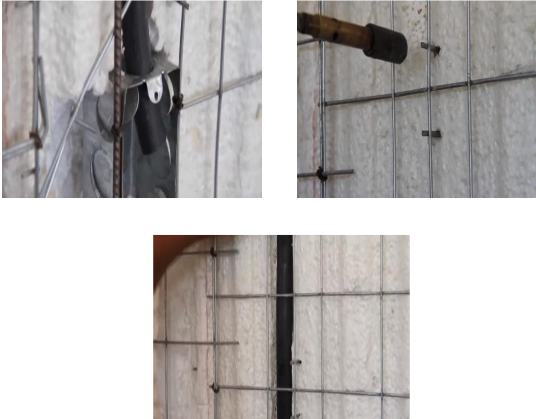
Figura 2. 2.2 .p.- Colocación de instalaciones. Tomada de.- (Hormi-2, 2013)
