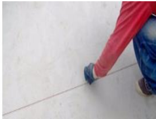
Figura 2.2.1.k.- Determinación de los ejes.
