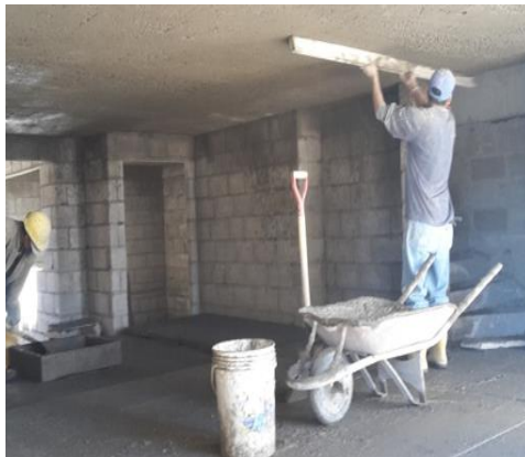
Figura 2.2.3 g.- Superficie alisada de la losa.
