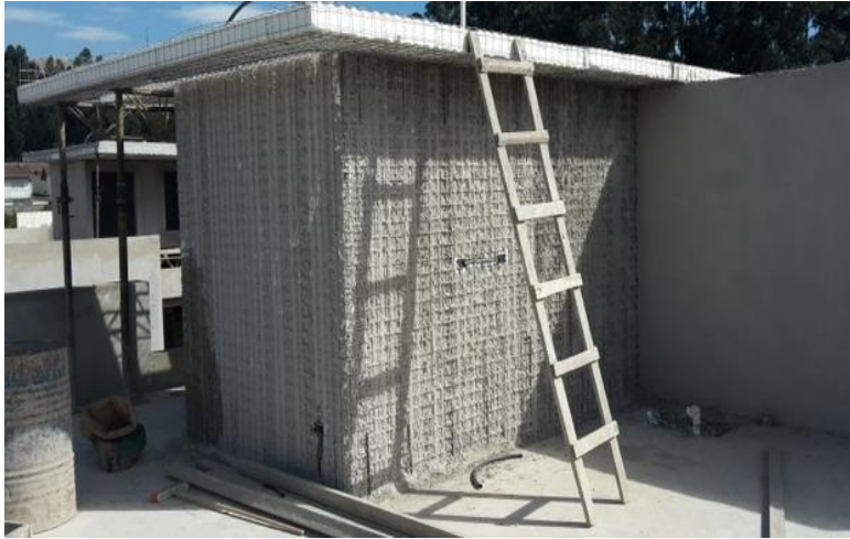
Figura 2. 2.2.t.- Desarrollo de obra.
