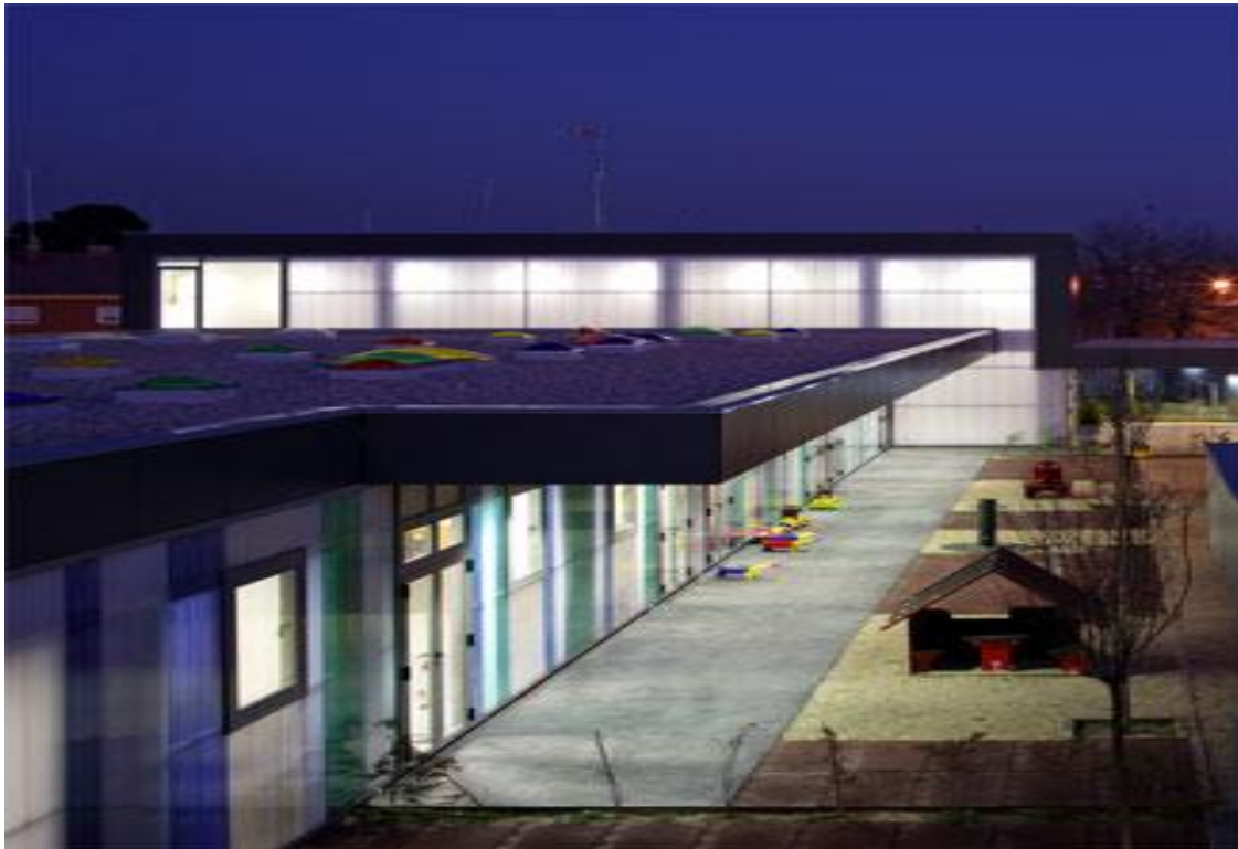
Vista exterior nocturna Escuela “La Corita”.
