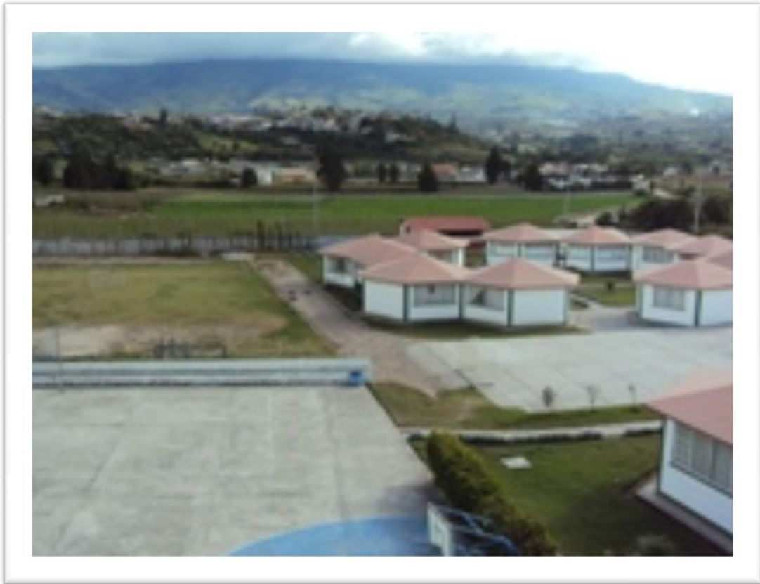
Fotografía N° 2. Vista exterior del Establecimiento.
