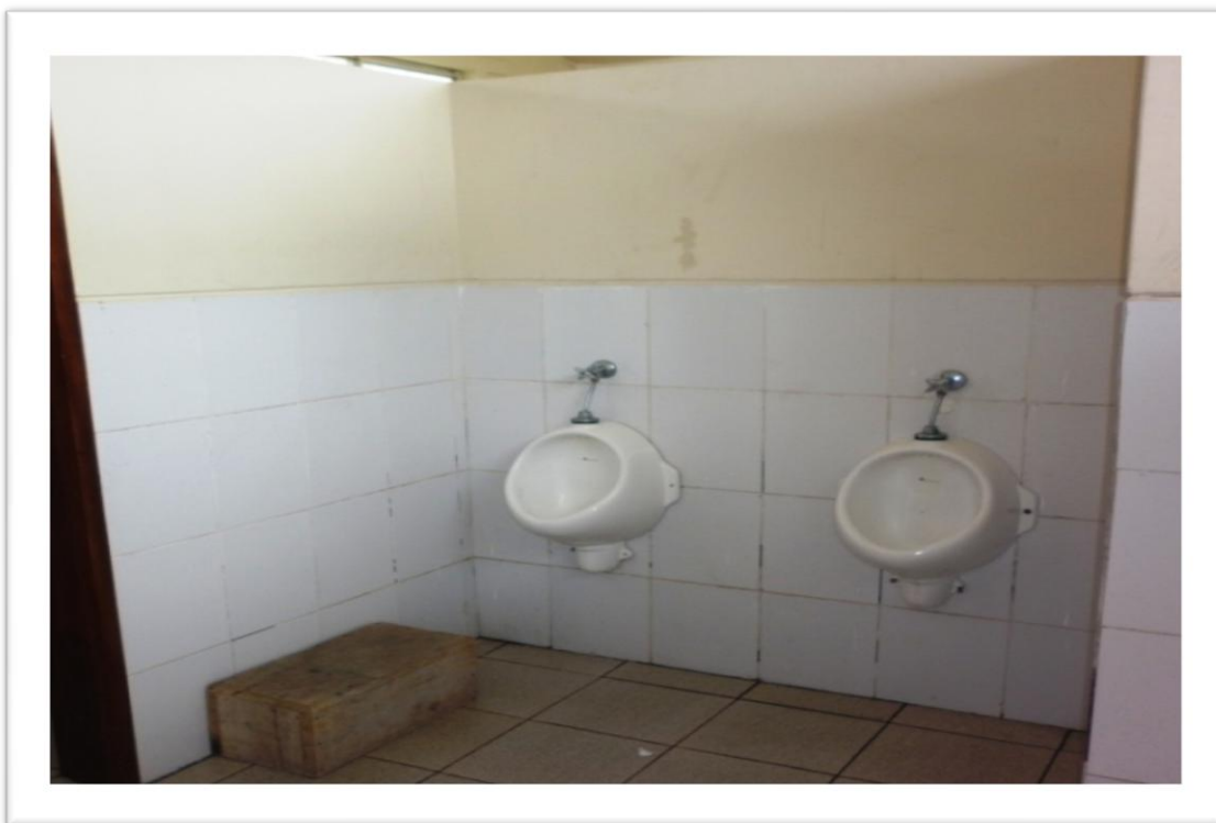
Fotografía N°5. Baños de niños.
