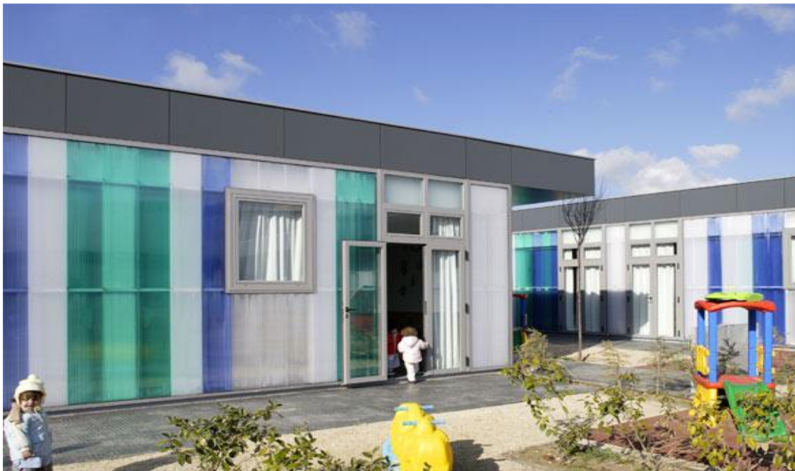
Patio exterior Escuela “La Corita”.
