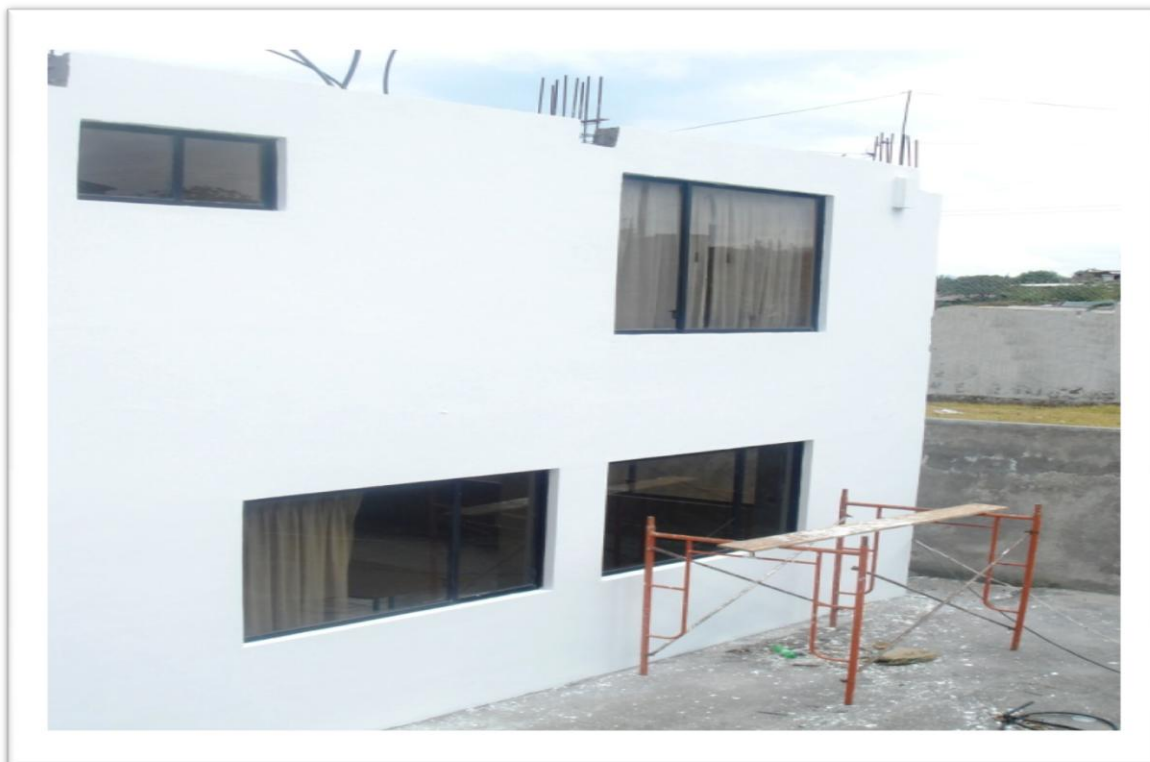
Fotografía N° 18. Fachada lateral derecha.
